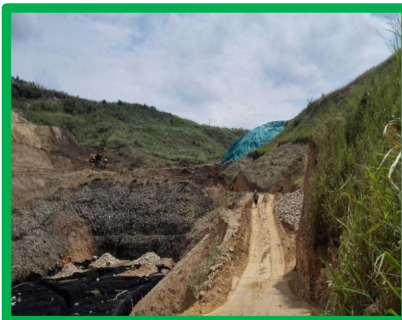
Conformación dren base del dique
