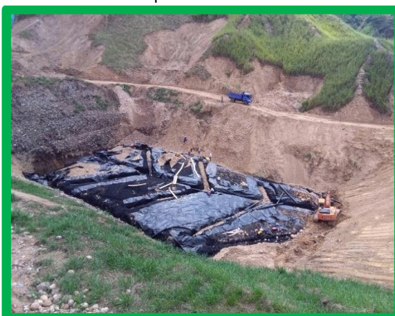
Conformación dren base del dique
