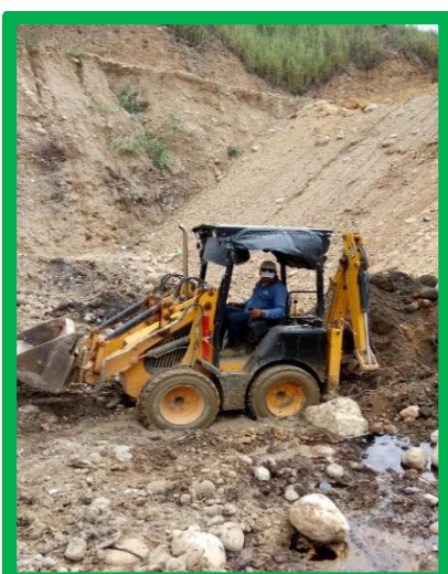
Excavaciones zanjas dren base del dique
