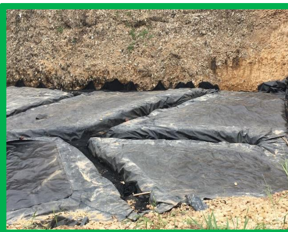
Impermeabilización dren del dique
