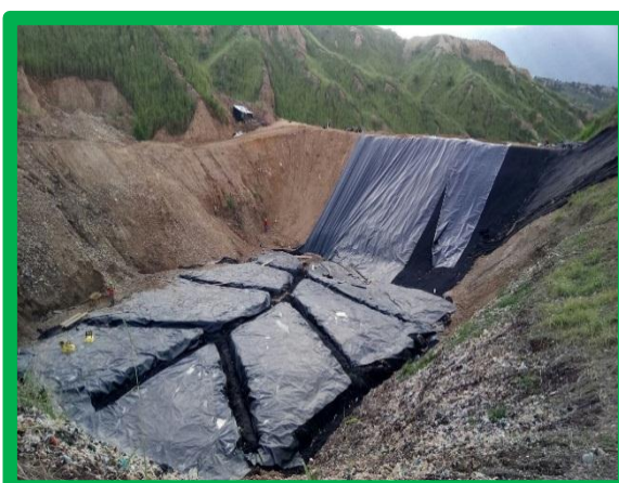
Impermeabilización dren del dique
