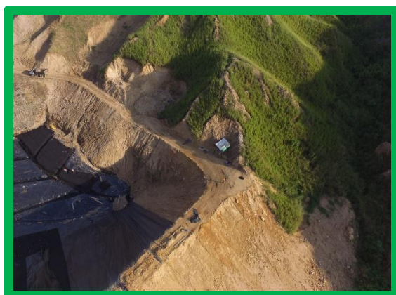
Dique construido de la celda
