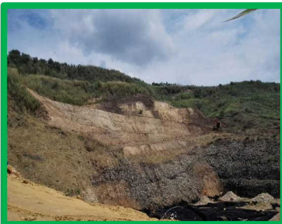
Desmonte, limpieza y perfilado de taludes
