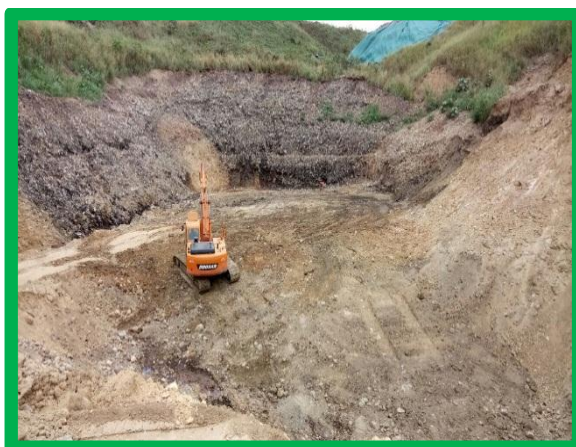
Finalización retiro de residuos sólidos
