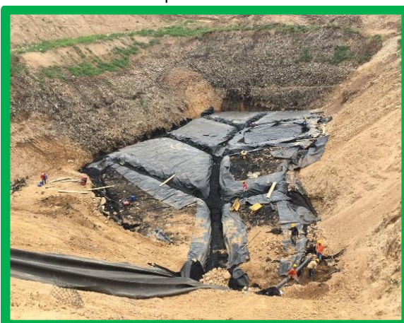
Conformación dren base del dique
