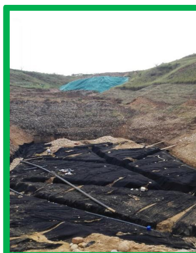
Conformación dren base del dique
