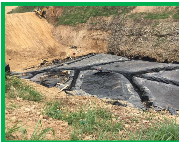
Impermeabilización dren base del dique
