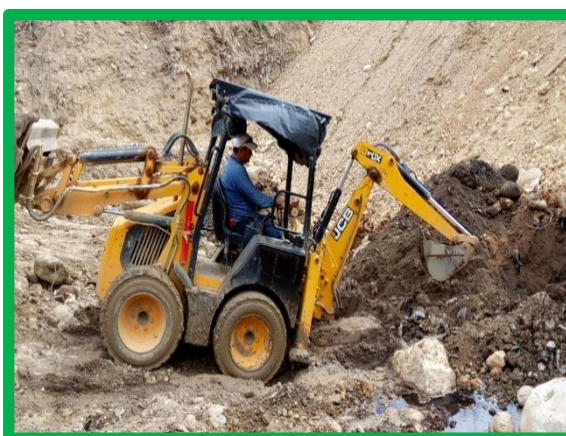
Excavaciones zanjas dren base del dique
