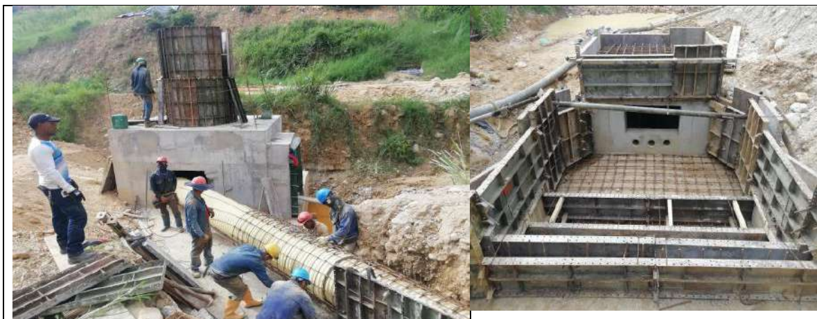
Ilustración 5. Registro fotográfico de la construcción del Box Culvert.
