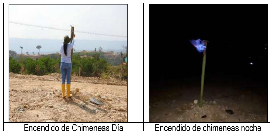
Ilustración 8. Registro fotográfico de encendido de chimeneas
