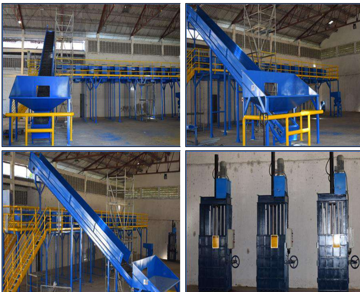
Ilustración 23. Maquinaria y equipos involucrados en la operación.
