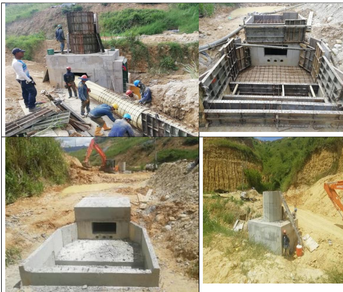
Ilustración 5. Registro fotográfico de la construcción del Box Culvert.
