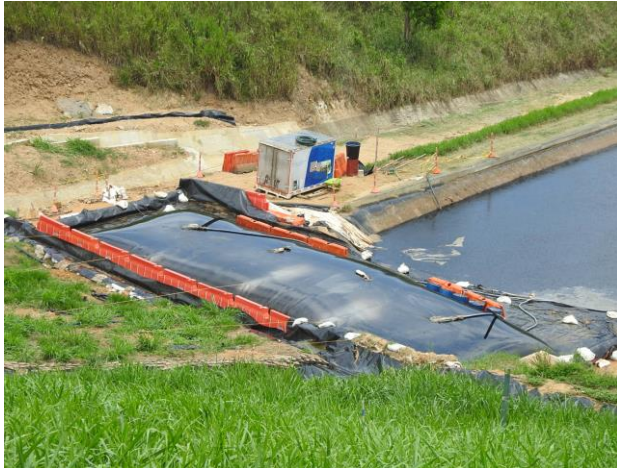
Extracción de sedimentos de los pondajes
