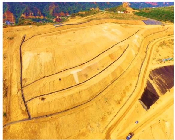
Manejo de Aguas de escorrentía
