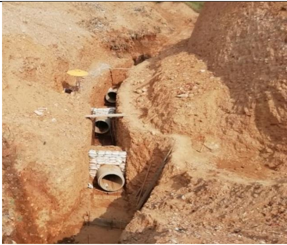
Construcción canales evacuación de escorrentía
