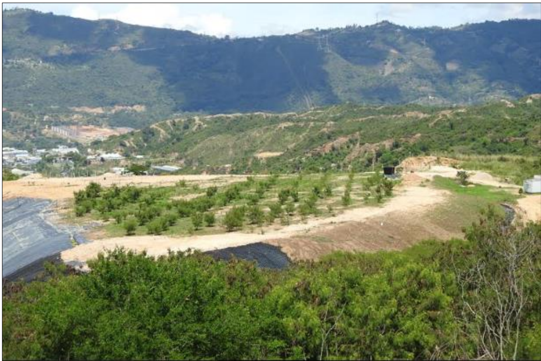
Celda 1, parte alta
