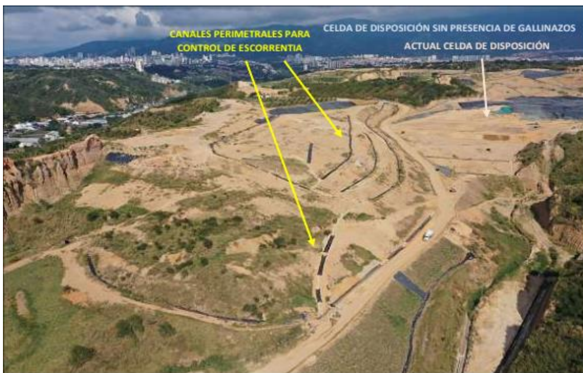
Sistemas perimetrales para el control y manejo de aguas lluvias
