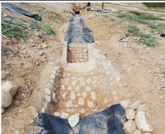
Manejo de Aguas de escorrentía
