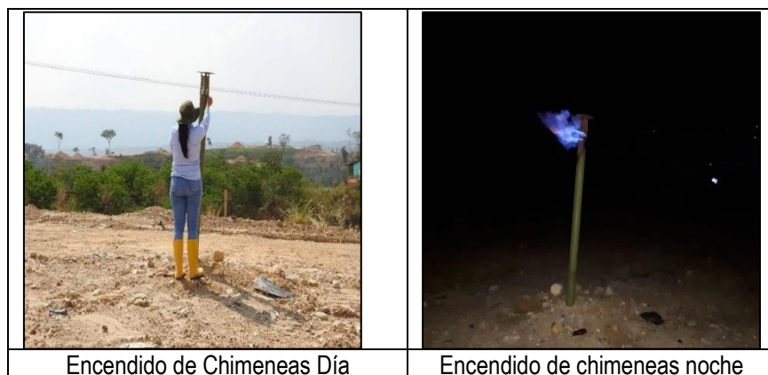
Ilustración 8. Registro fotográfico de encendido de chimeneas
