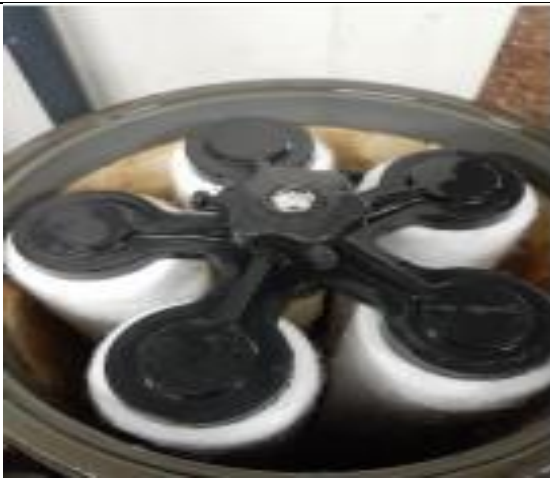
Unidad de micro filtración y las membranas
