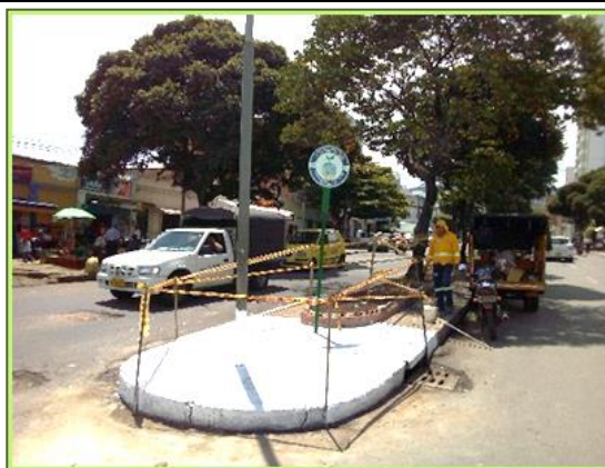
Punto Crítico Calle 14 con Carrera 24. Después de la Intervención.
