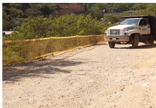
Señalización y protección de vías internas
