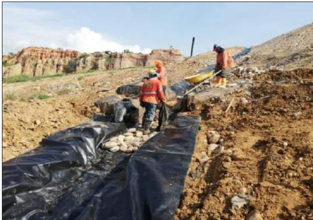
*Ilustración 16 Canales superficiales de aguas lluvia*
