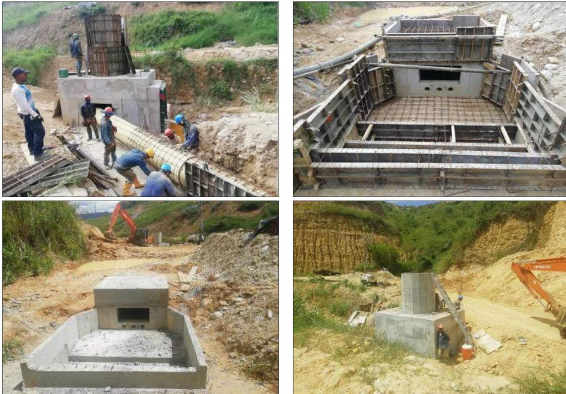
*Ilustración 20 Registro fotográfico de la construcción del Box Culvert*
