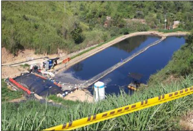
*Ilustración 14 Extracción sedimentos pondaje N°1 y sistemas perimetrales para el control y manejo de aguas lluvias*
