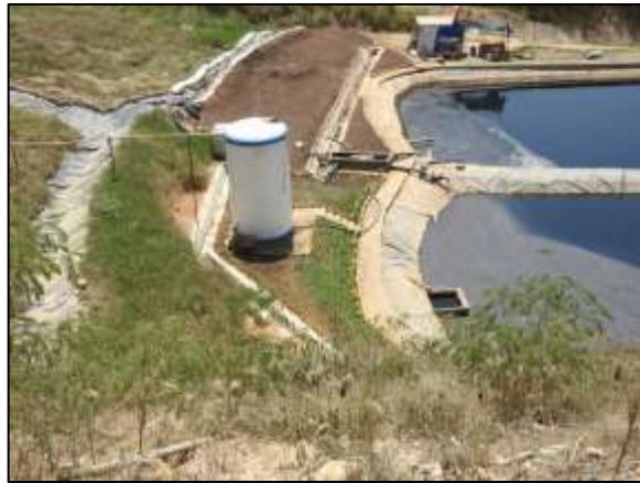
Ilustración 17 Siembra de material vegetal en alrededores de las piscinas de lixiviados.
