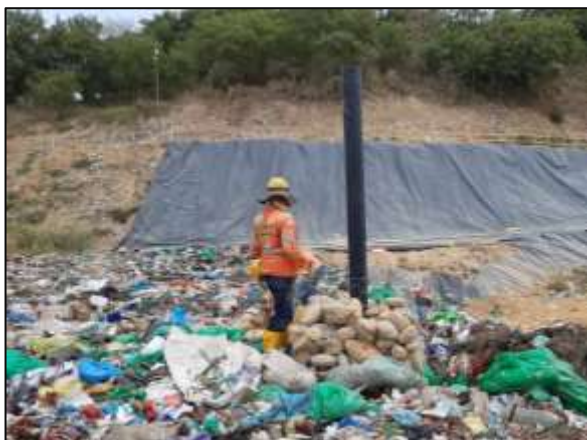
Ilustración 25 Realce de chimeneas celda de respaldo 1.
