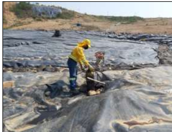
Ilustración 30 Extracción forzada de lixiviados pozo 1 celda 4.
