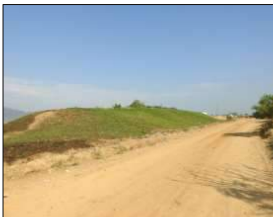
Ilustración 18 Mantenimiento de la cobertura vegetal del talud de la celda 1.
