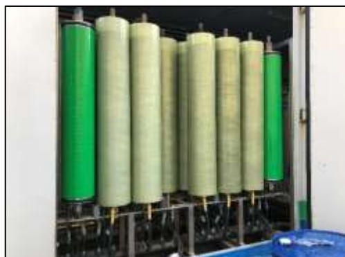
Ilustración 33 Reemplazo de membranas y discos
