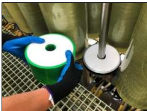
Ilustración 33 Reemplazo de membranas y discos
