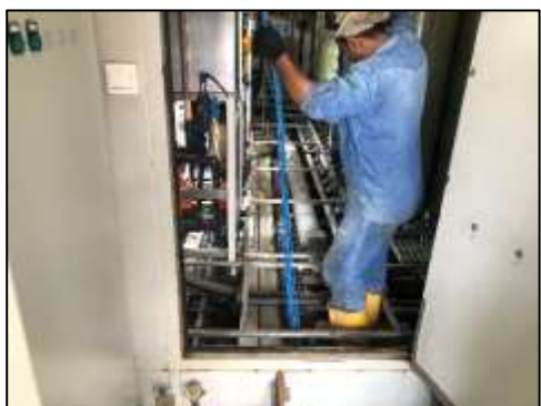
Ilustración 35 Reemplazo manguera neumática
