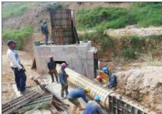
Ilustración 12 Registro fotográfico de la construcción del Box Culvert
