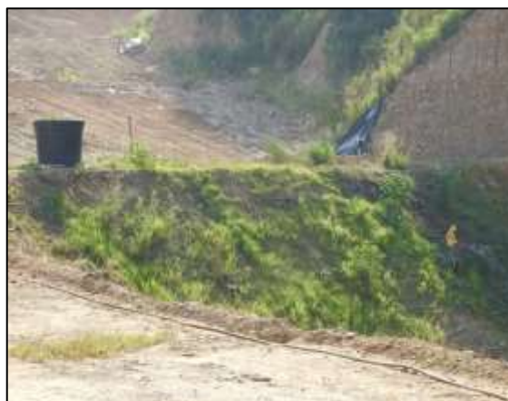
Ilustración 19 Mantenimiento de cobertura del dique celda de respaldo 1.
