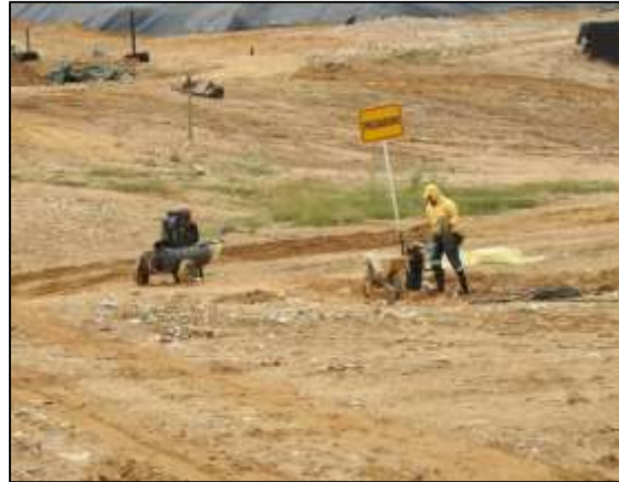
Ilustración 28 Extracción forzada de lixiviados pozos 4 celda de respaldo 1.
