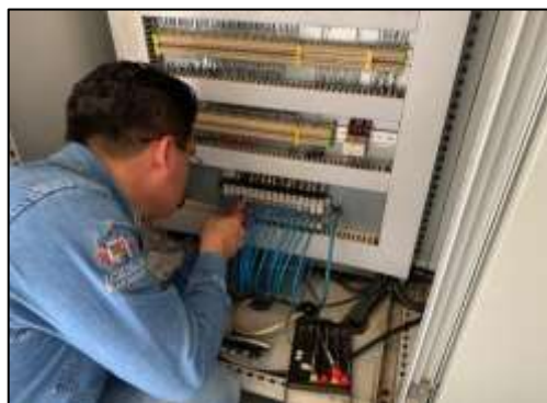
Ilustración 34 Reemplazo de electroválvulas
