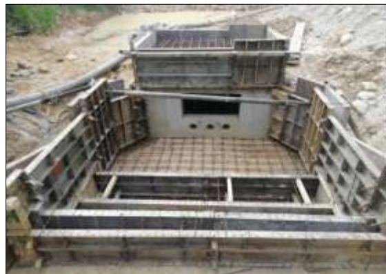
Ilustración 12 Registro fotográfico de la construcción del Box Culvert
