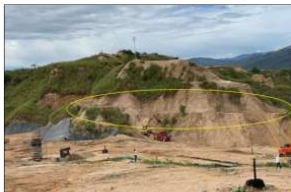
Ilustración 14 Inicios de excavación
