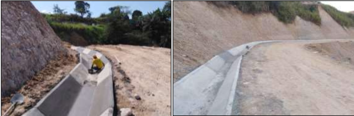
Ilustración 15 Canales Finalizados
