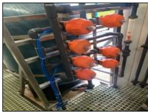
Ilustración 36 Bomba de alta presión tipo pistón
