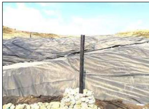
Ilustración 26 Construcción de chimeneas celda de respaldo 1.
