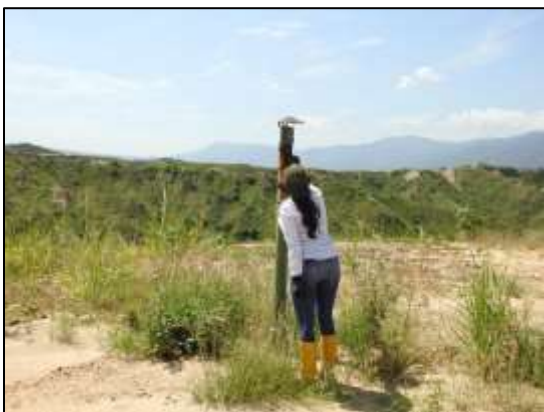
Ilustración 23 . Encendido de chimeneas en el sitio de disposición final El Carrasco.
