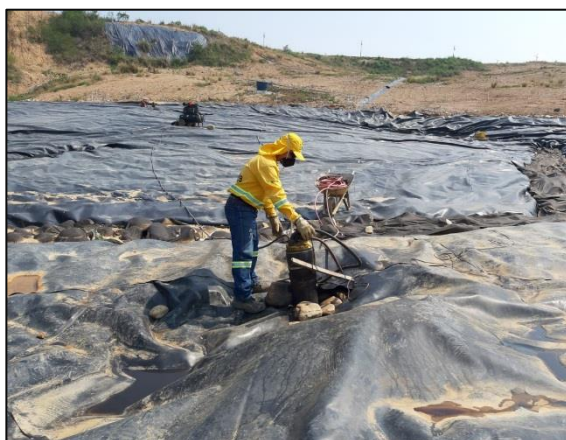
Ilustración 25 Extracción forzada de lixiviados pozo 1 celda 4.
