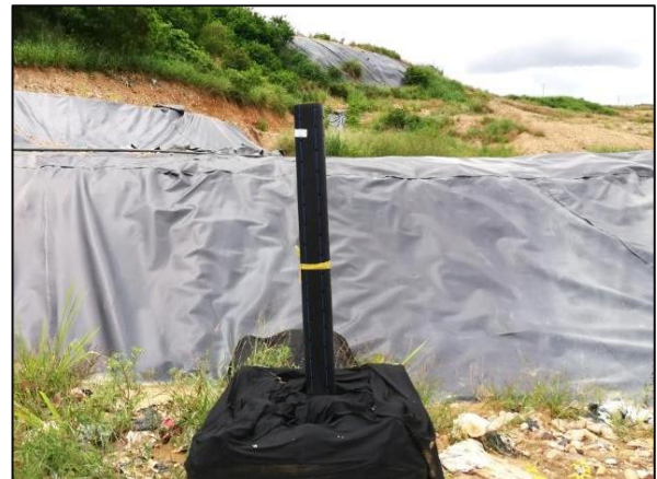
Ilustración 19 Construcción de chimeneas celda de respaldo 1.
