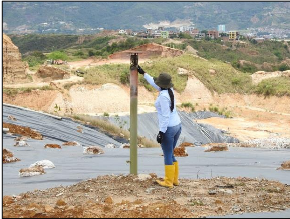
Ilustración 16 Encendido de chimeneas en el sitio de disposición final El Carrasco.
