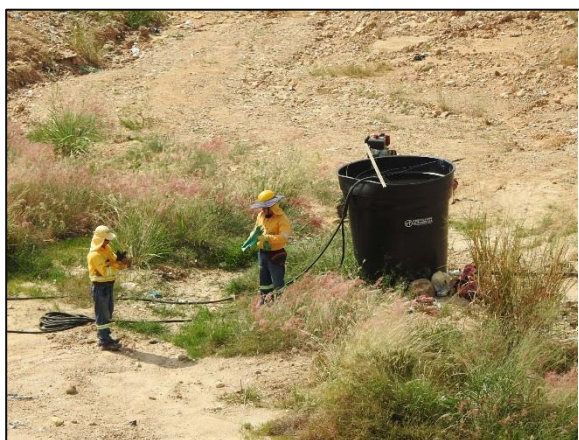
Ilustración 24 Extracción forzada de lixiviados pozo 5 celda 4.
