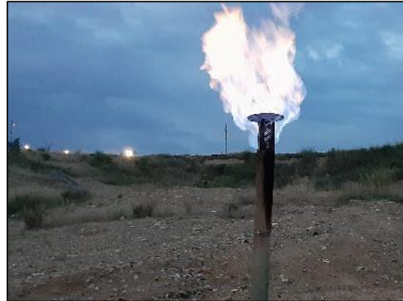
Ilustración 17 Verificación de chimeneas encendidas en el recorrido de las 6:00 pm.
