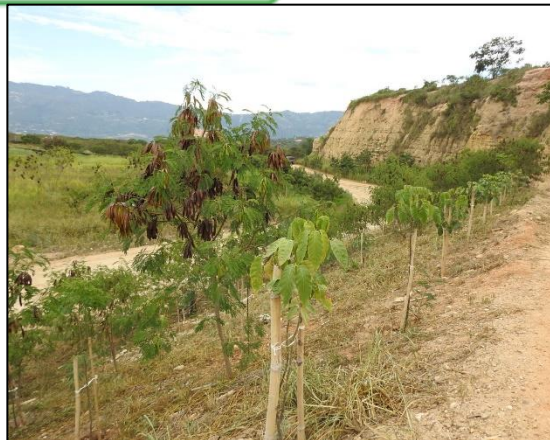
Ilustración 12 Mantenimiento de cobertura arbórea del talud de la escombrera.
