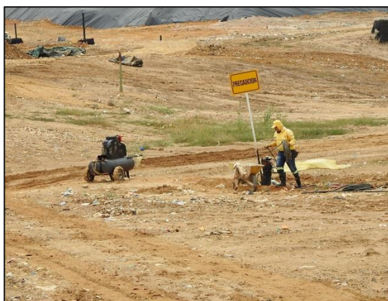
Ilustración 23 Extracción forzada de lixiviados pozos 4 celda de respaldo 1.
