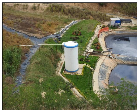
Ilustración 10 Siembra de material vegetal en alrededores de las piscinas de lixiviados.
