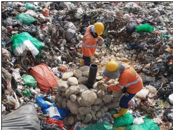
Ilustración 18 Realce de chimeneas celda de respaldo 1.
