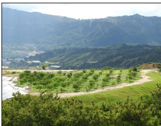
Ilustración 9 Mantenimiento de zonas clausuradas (Domo de la celda 1).
