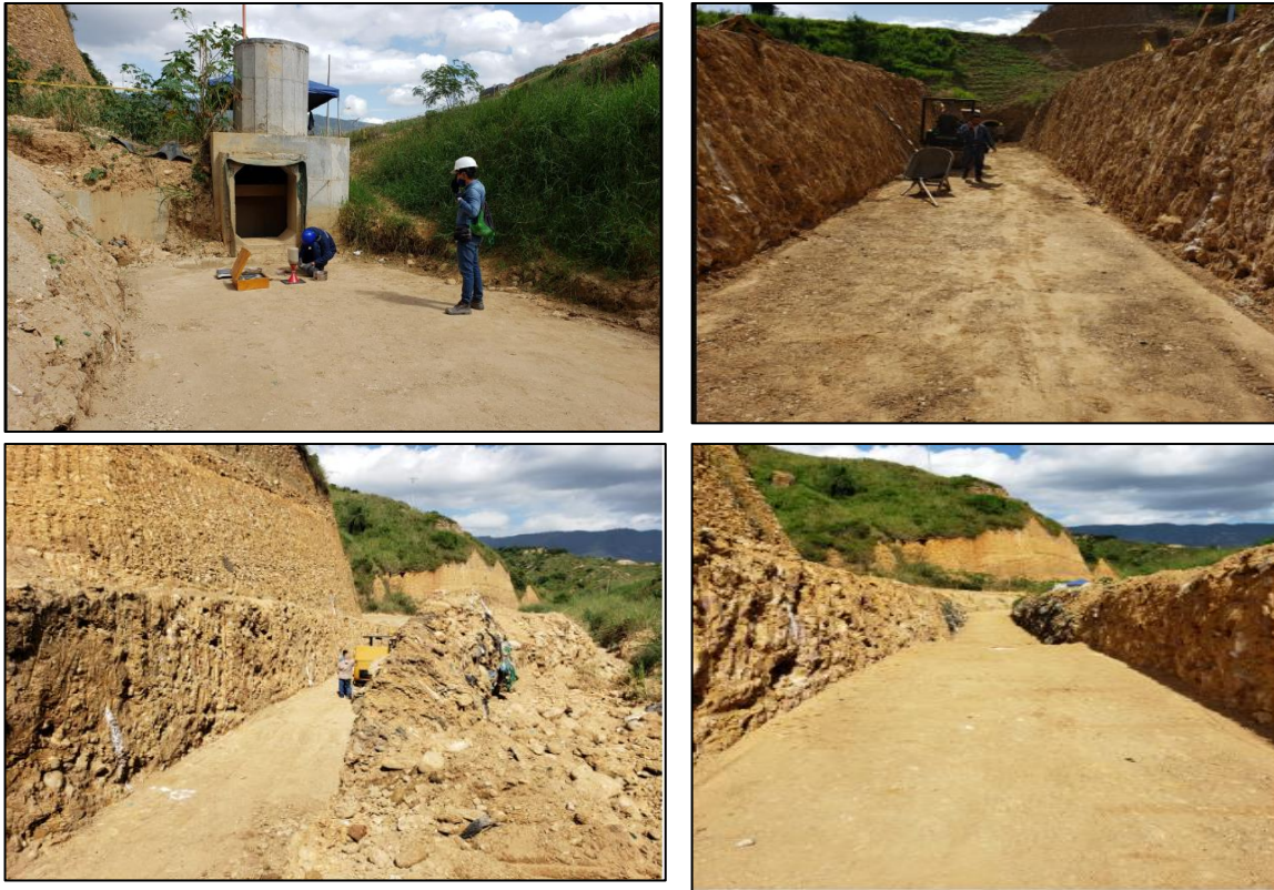
Ilustración 5 Registro fotográfico de la construcción del Box Culvert
