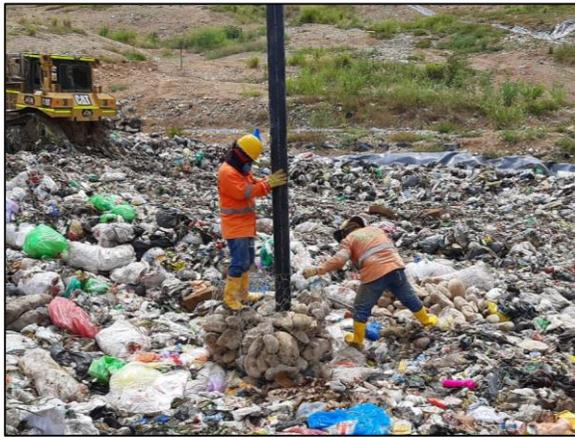
*Ilustración 18 Realce de chimeneas celda de respaldo 1.*
