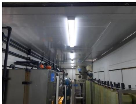
Aplicación de pintura en la parte interna del contenedor de la DTRO; se pintaron paredes, techo y puertas del contenedor
