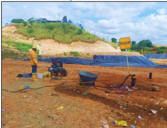
Ilustración 21 Extracción forzada de lixiviado pozo 2 celda 4.
