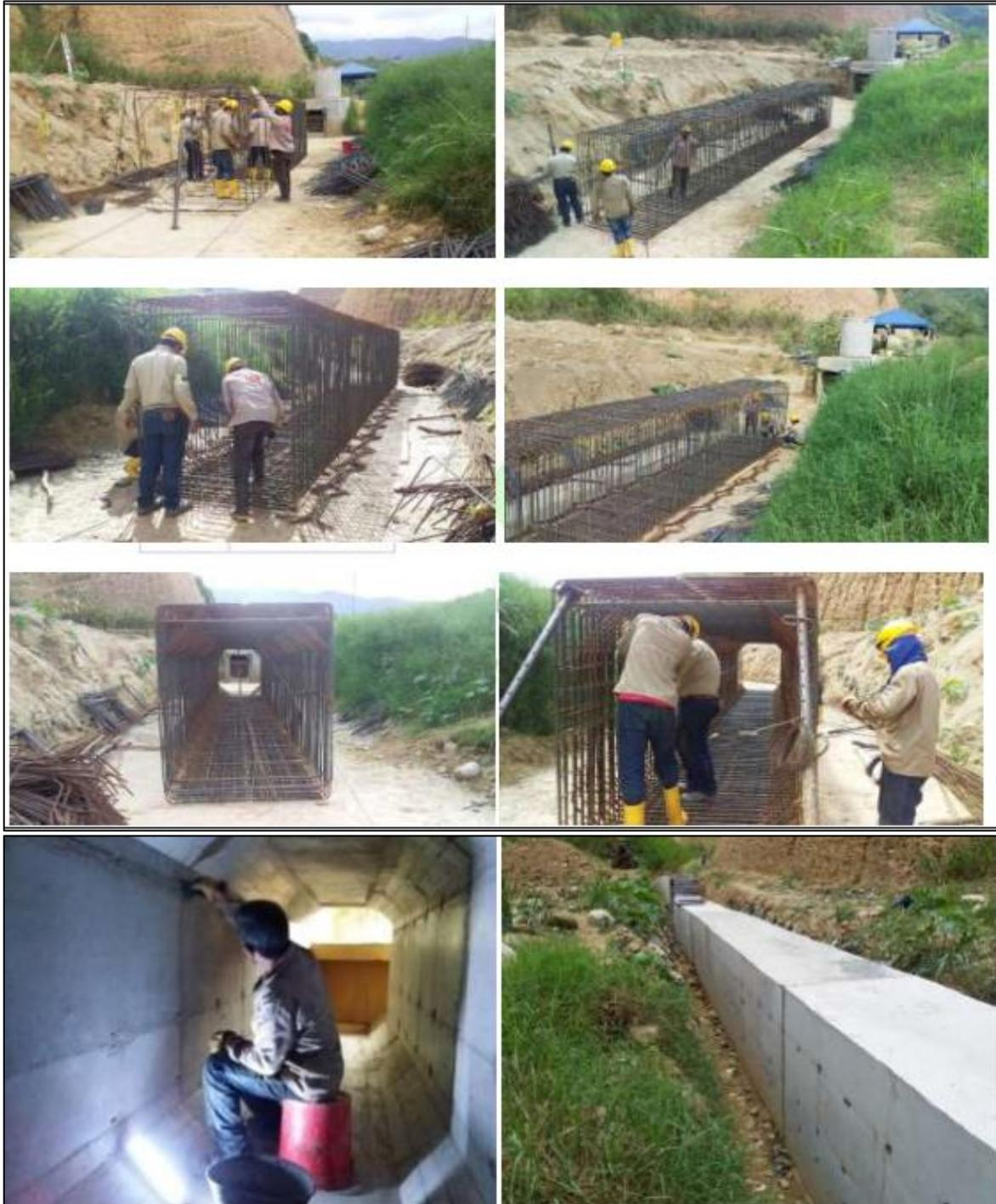
*Ilustración 4 Registro fotográfico de la construcción del Box Culvert*
