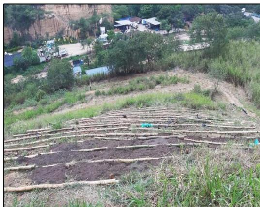
*Ilustración 11 Reconformación de la superficie del talud de la celda 3.*
