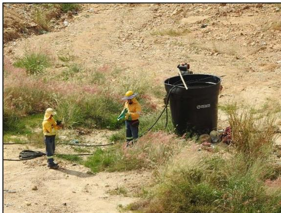
Ilustración 23 Extracción forzada de lixiviados pozo 5 celda 4.
