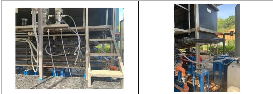
*Ilustración 27 Mantenimiento mangueras de conducción de lixiviado y químico en el DAF*
