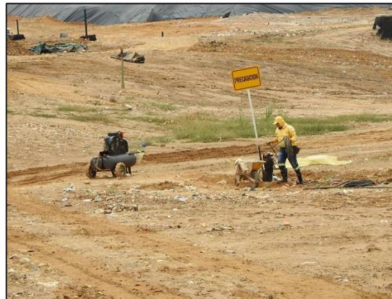
Ilustración 22 Extracción forzada de lixiviados pozos 4 celda de respaldo 1.
