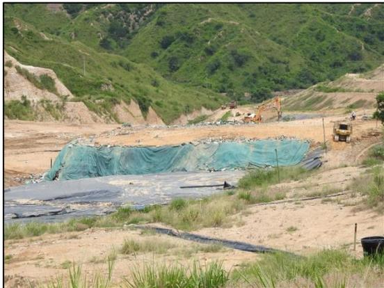
*Ilustración 14 Cobertura temporal de los residuos sólidos para limitar el área de atracción*
