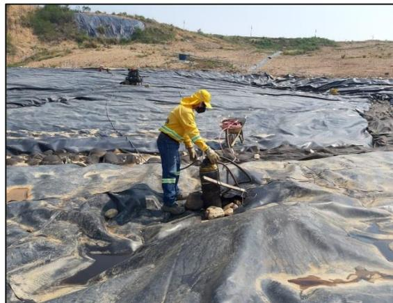
Ilustración 24 Extracción forzada de lixiviados pozo 1 celda 4.
