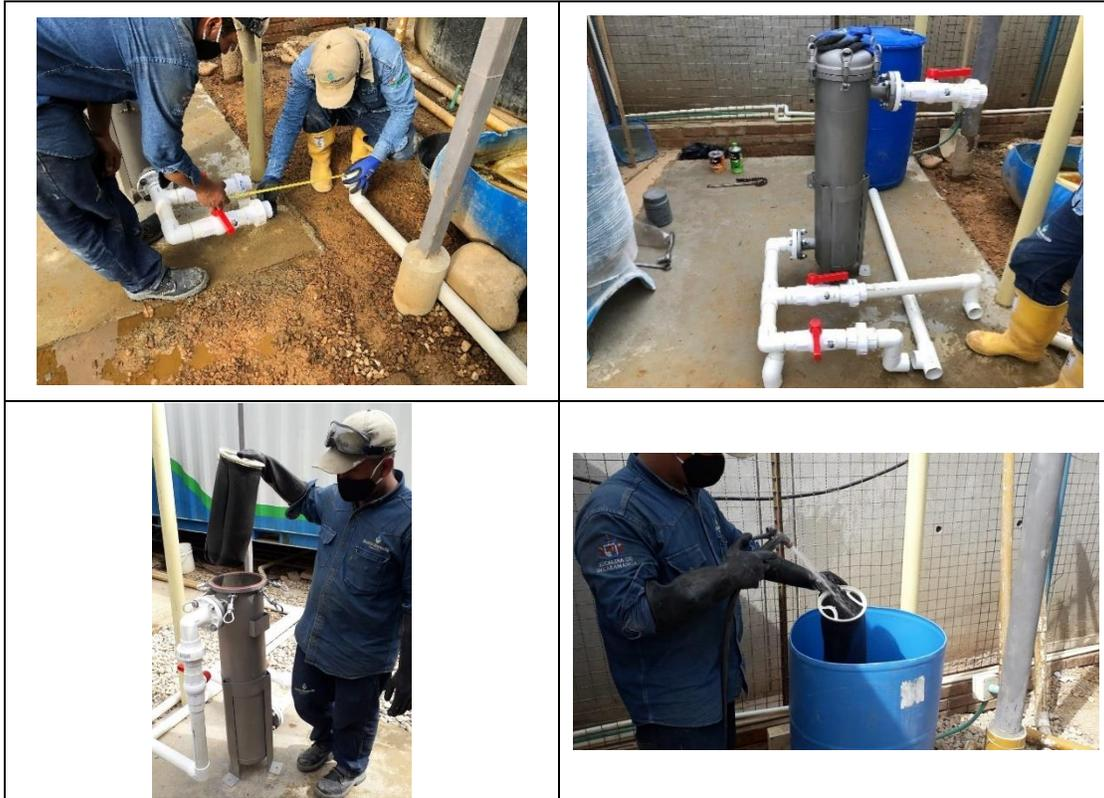
*Ilustración 26 Adquisición de equipos e instalación de la nueva unidad de microfiltración.*
