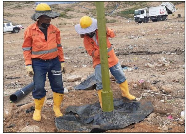
*Ilustración 19 Construcción de chimeneas celda de respaldo 1*
