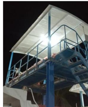
Pintura de los soportes y la plataforma del filtro prensa
