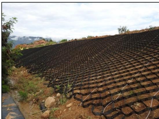
*Ilustración 7 Instalación de 900 m2 de geocelda en el talud de la celda 1*
