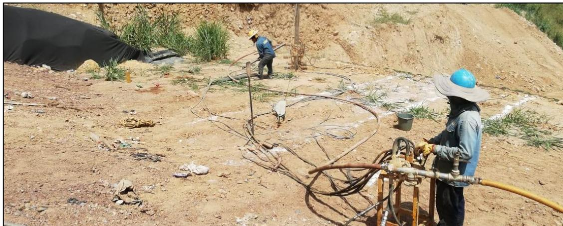
*Ilustración 4 Instalación de equipos de perforación*
