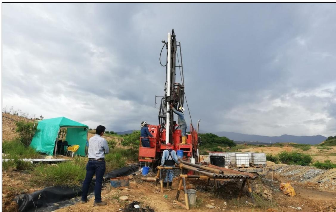
*Ilustración 6 Instalación de piezómetro sector izquierdo celda N°.1*
