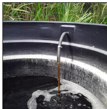
Ilustración 25 Extracción forzada de lixiviados pozos 2 celda 3.
