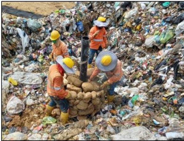
*Ilustración 17 Realce de chimeneas celda de respaldo 2.*
