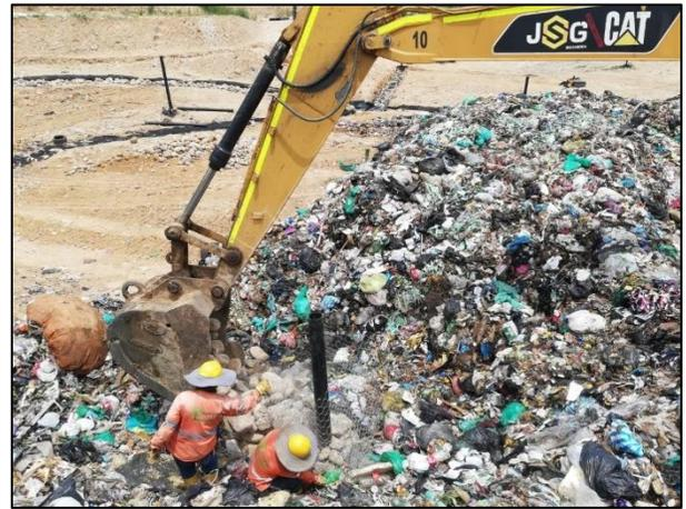
*Ilustración 18 Realce de chimeneas celda de respaldo 2.*
