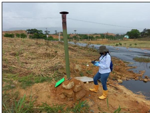
Ilustración 21 Realce de chimeneas celda 4.
