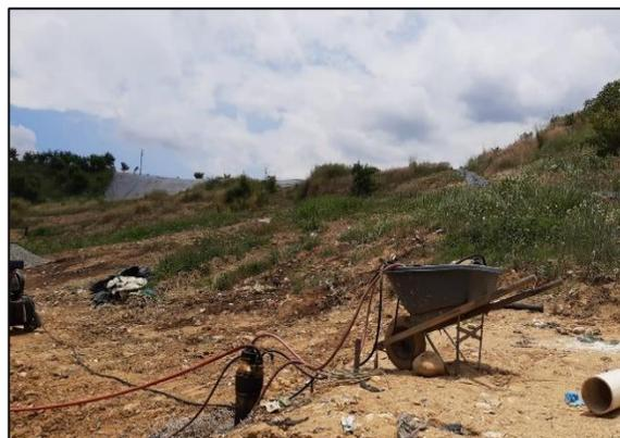
Ilustración 23 Extracción forzada de lixiviados pozos 14 celda 4
