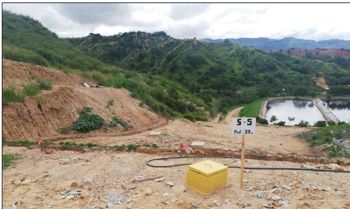
*Ilustración 5 Construcción caja superficial de inspección*
