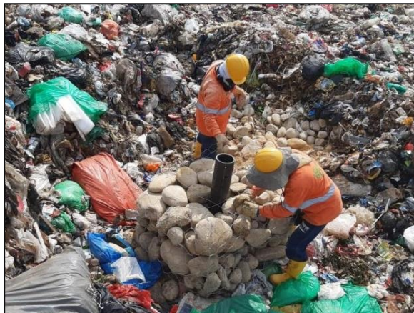
Ilustración 18 Realce de chimeneas celda de respaldo 1.
