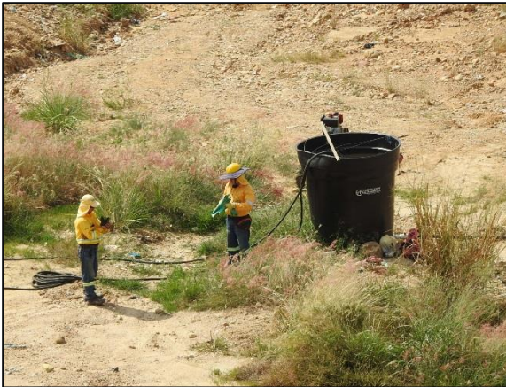
Ilustración 24 Extracción forzada de lixiviados pozo 5 celda 4.
