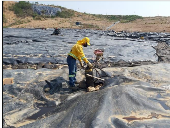
Ilustración 25 Extracción forzada de lixiviados pozo 1 celda 4.
