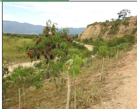
Ilustración 12 Mantenimiento de cobertura arbórea del talud de la escombrera.
