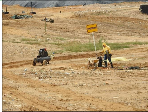
Ilustración 23 Extracción forzada de lixiviados pozos 4 celda de respaldo 1.
