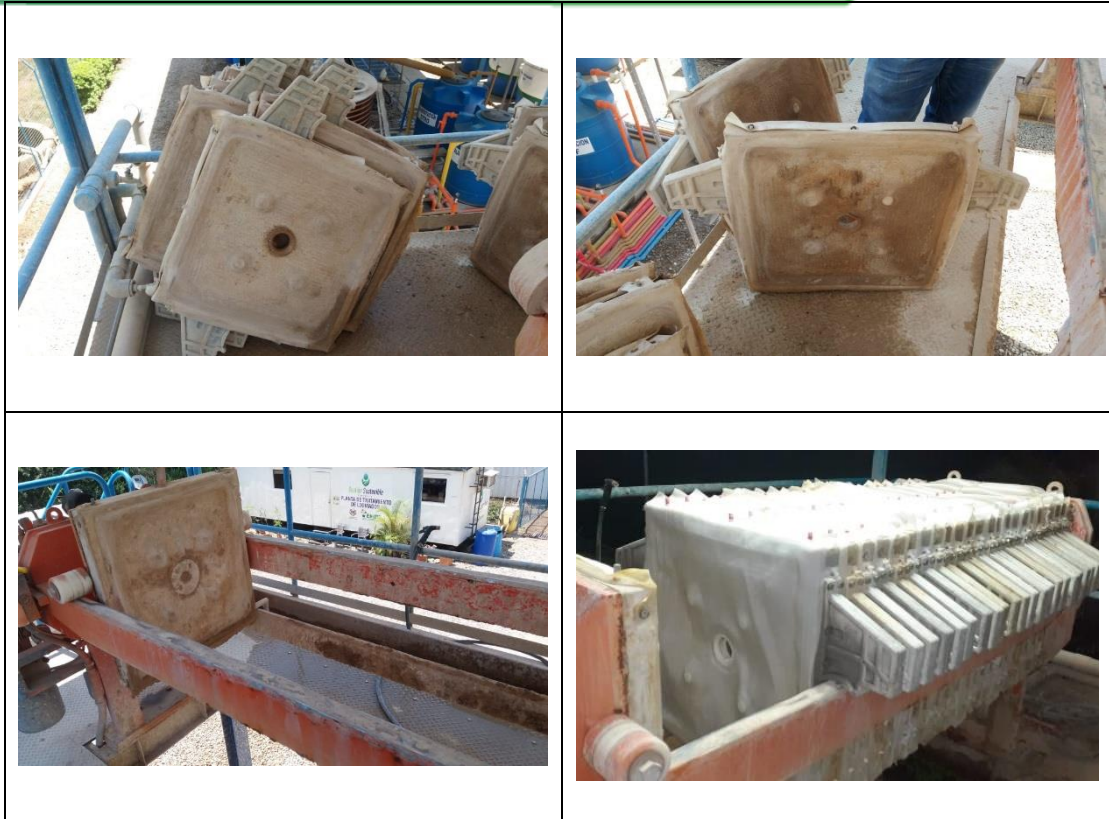
Ilustración 28 Mantenimiento al filtro prensa
