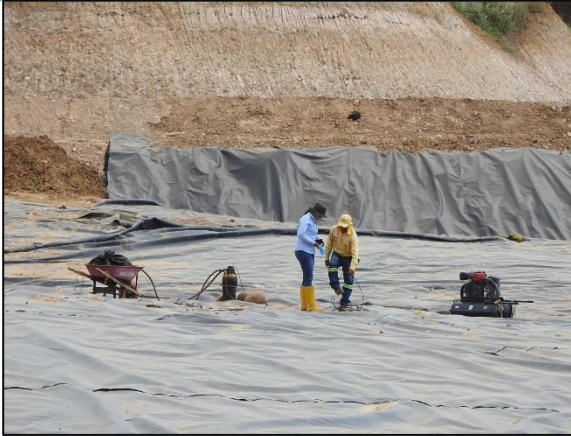
Ilustración 22 Extracción forzada de lixiviado pozo 2 celda 4.
