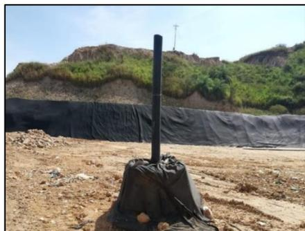
Ilustración 17 16 Realce de chimeneas celda de respaldo 2
