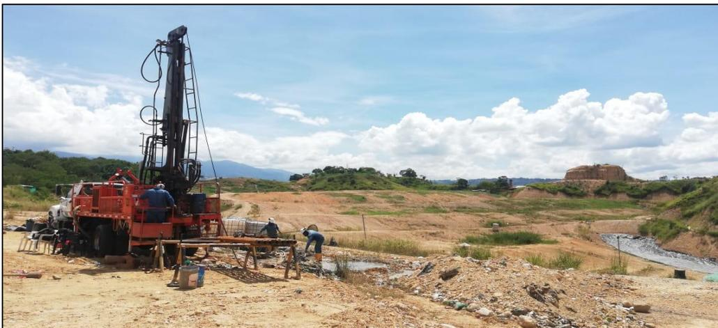
Ilustración 3 Instalación de piezómetro sector central de la celda N°1 (PZ HV 3)
