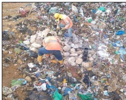
Ilustración 15 Realce de chimeneas celda de respaldo 2
