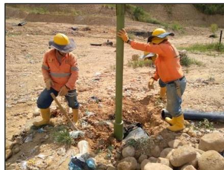
Ilustración 18 Instalación de chimeneas celda de respaldo 2
