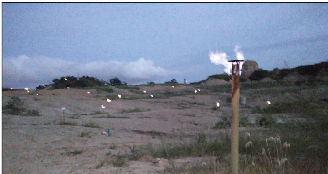
Ilustración 14 Verificación de chimeneas encendidas en el recorrido de las 6:00pm
