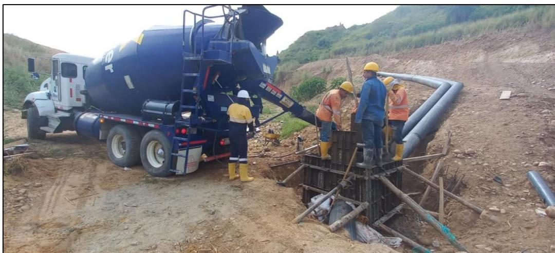
Ilustración 6 Fundida de la caja colectora
