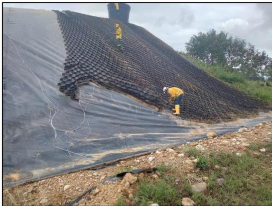
Ilustración 7 Instalación de 700 m2 de geocelda en el talud de la celda 4
