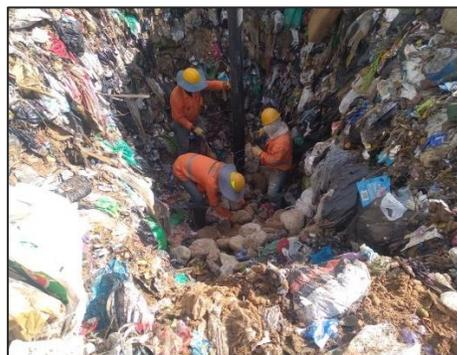
Ilustración 16 Realce de chimeneas celda de respaldo 2
