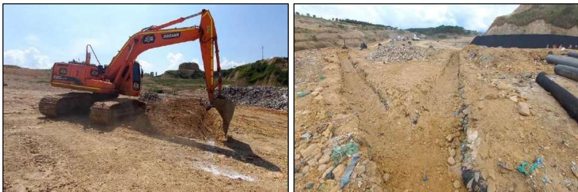
*Ilustración 7 Excavación en zanja sobre residuos sólidos sub dren tipo 1*
