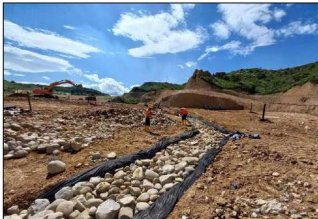
Ilustración 12 Construcción sub dren de lixiviados tipo 1
