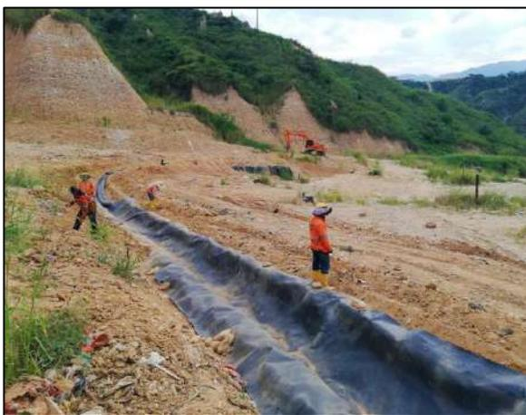
Ilustración 22 Construcción de canales superficiales en geomembrana HDPE
