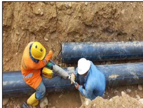
Ilustración 17 Construcción de ducto doble de lixiviados
