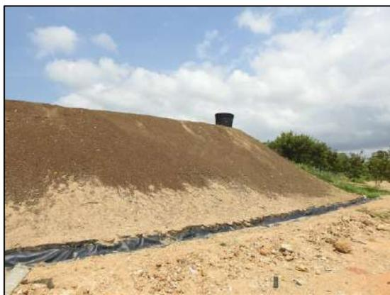
Ilustración 27 Instalación capa de infiltración y orgánica en los 700 m<sup>2</sup> de geocelda en el talud de la celda 4
