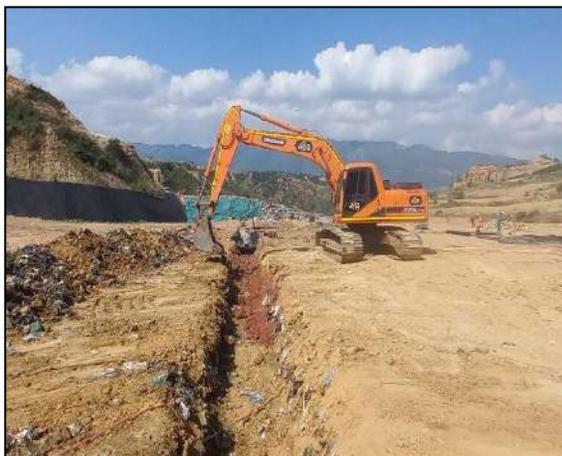
*Ilustración 8 Excavación en zanja sobre residuos sólidos sub dren tipo 1*
