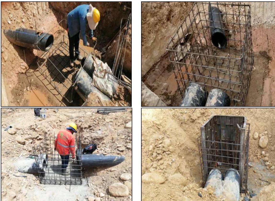
*Ilustración 21 Instalación de acero de refuerzo*
