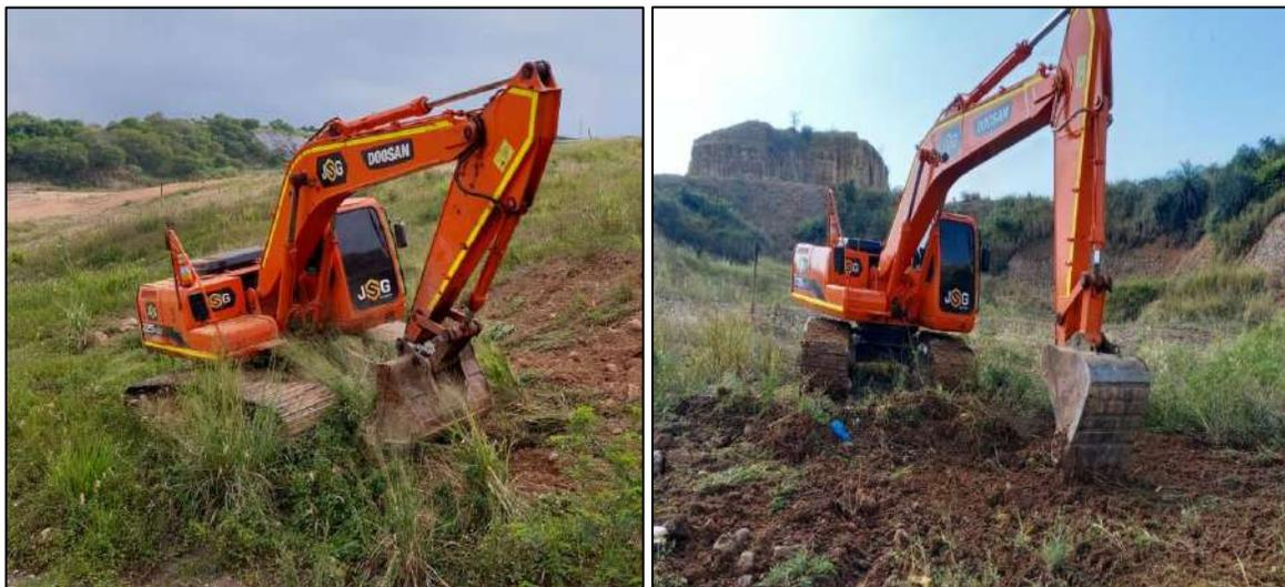
*Ilustración 5 limpieza y descapote de la superficie de trabajo*
