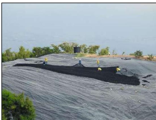
*Ilustración 29 Instalación de 4300 m2 de geocelda en el talud de celda*
