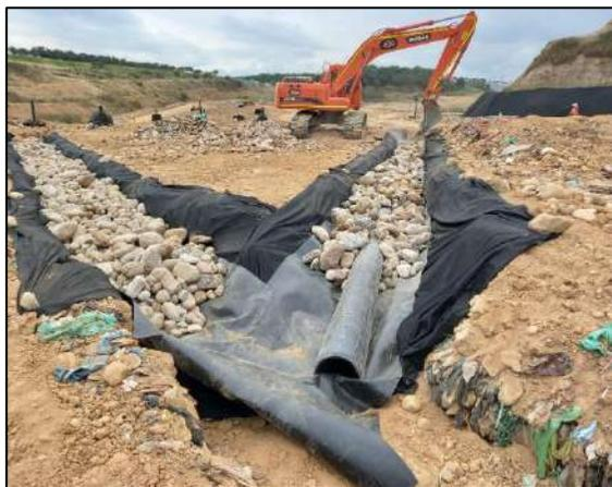
Ilustración 13 Sub dren de lixiviados tipo 2
