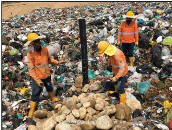
*Ilustración 36 Realce de chimeneas celda actual de disposición*
