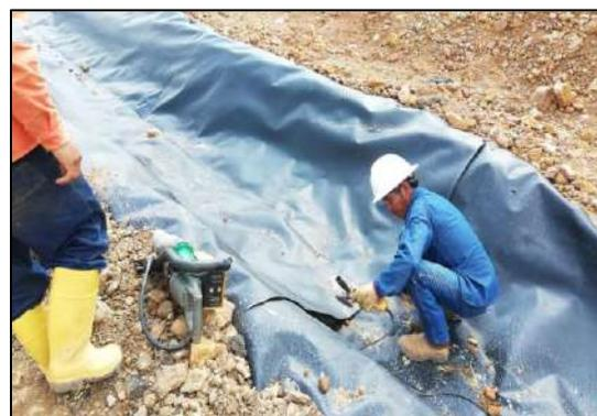
Ilustración 25 Canales superficiales en geomembrana HDPE
