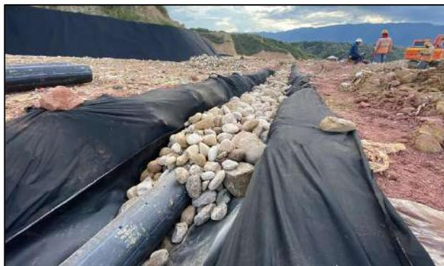
Ilustración 15 Construcción de sub dren de lixiviados tipo 2
