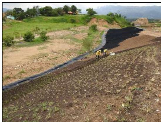
Ilustración 28 Siembra de material vegetal en talud de la celda 4
