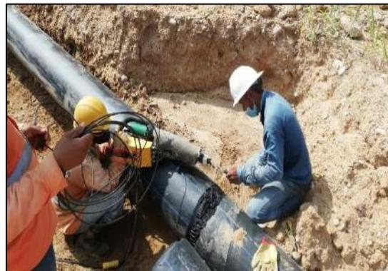
Ilustración 19 Construcción de ducto doble de lixiviados
