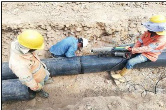
Ilustración 18 Construcción de ducto doble de lixiviados
