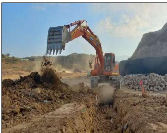
*Ilustración 9 Reconformación de zanja de drenaje*
