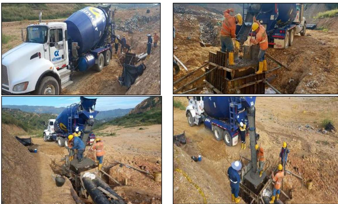
*Ilustración 20 Fundida de cajas recolectoras de lixiviados*
