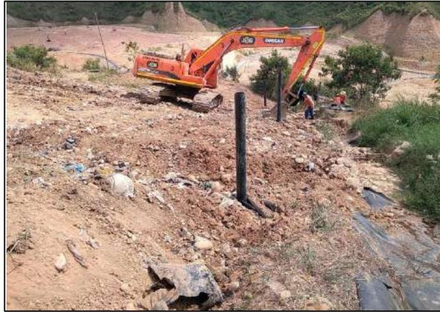
*Ilustración 38 Construcción de chimeneas celda de contingencia.*
