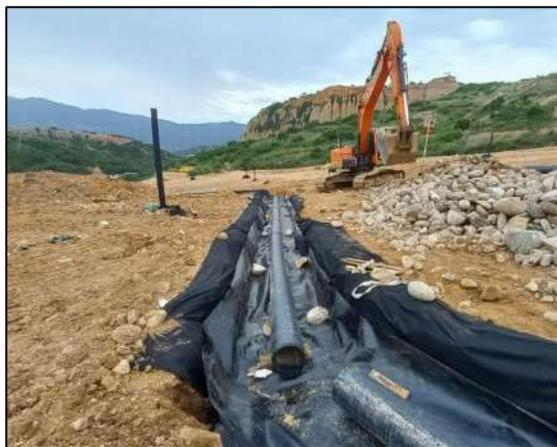
Ilustración 14 Construcción de sub dren de lixiviados tipo 2
