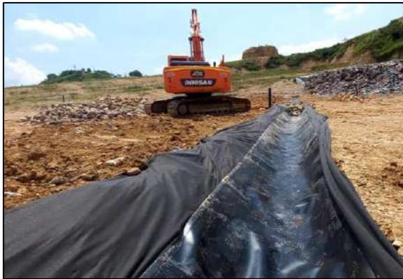
Ilustración 10 Instalación de geomembrana HDPE y geotextil NT
