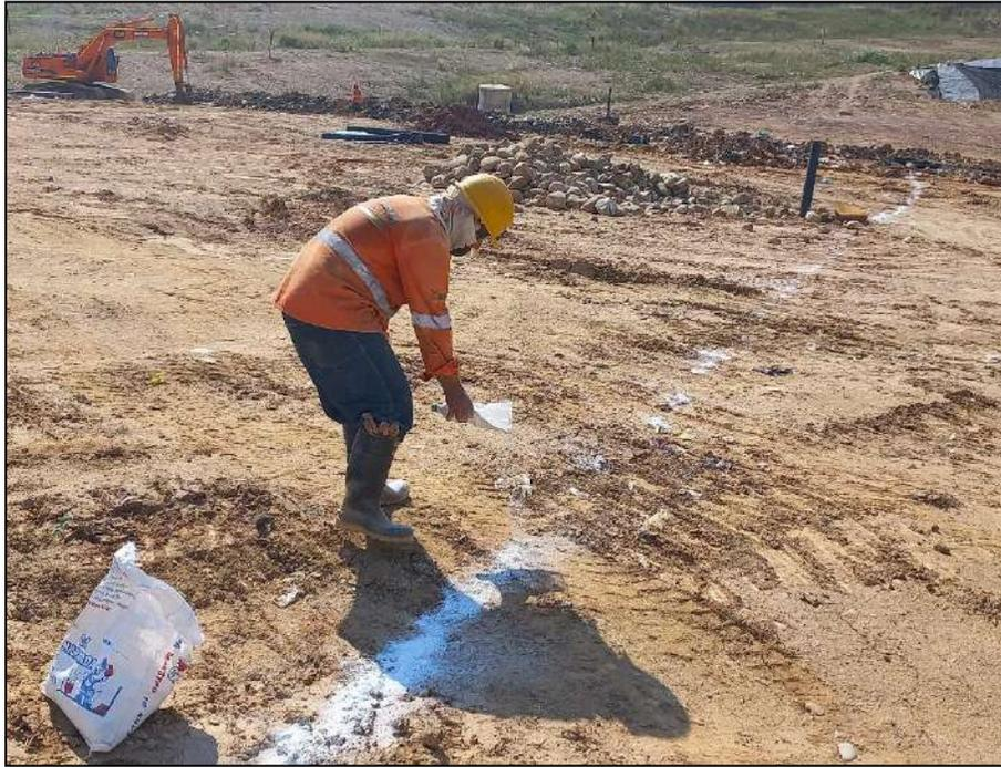
*Ilustración 2 Localización y marcación de lineamientos de sistemas de captación y conducción de lixiviados*
