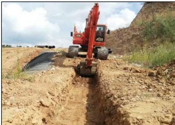
Ilustración 16 Excavación e instalación de tubería HDPE de 16"
