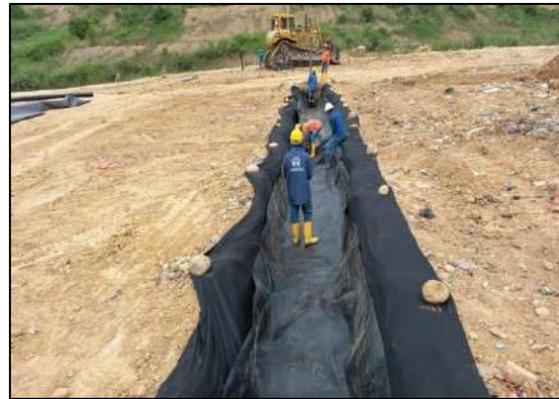
Ilustración 11 Construcción sub dren de lixiviados tipo 1
