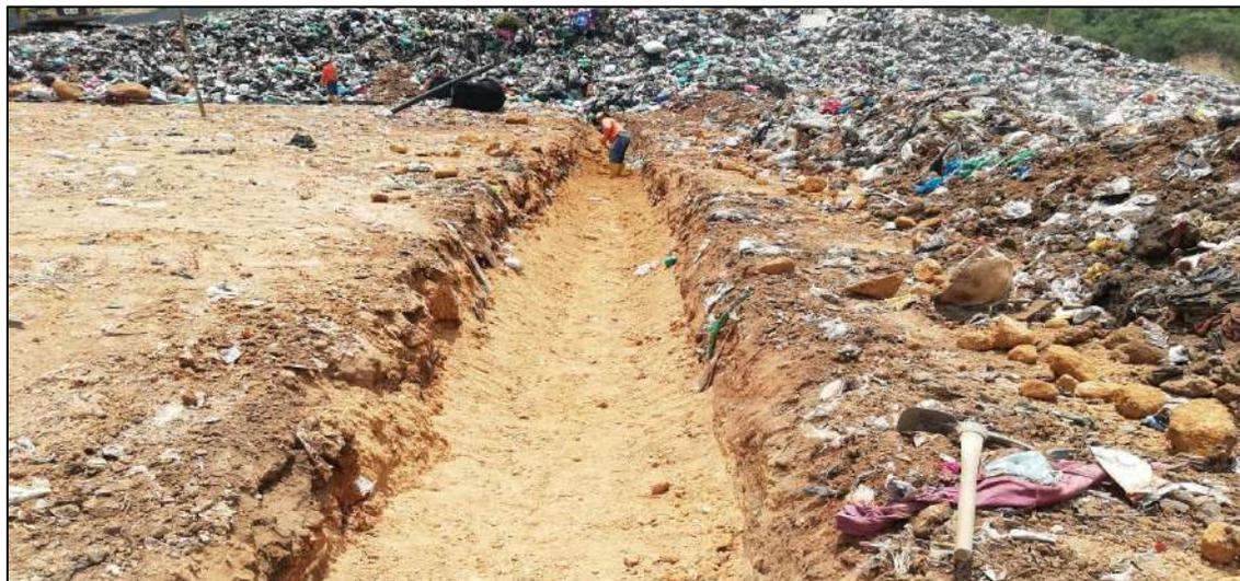
*Ilustración 6 Mejoramiento de suelo y reconfiguración de zanja de drenaje*
