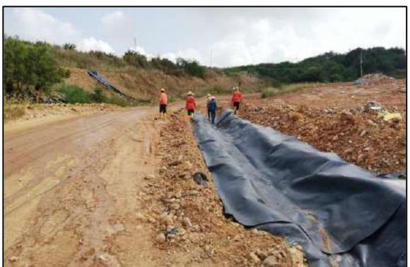
Ilustración 24 Canales superficiales en geomembrana HDPE
