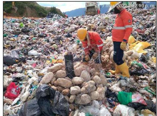
*Ilustración 37 Realce de chimeneas celda actual de disposición*
