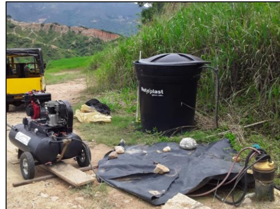
Ilustración 15 Extracción forzada de lixiviados pozos 2 celda 3.
