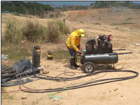
Ilustración 14 Extracción forzada de lixiviado pozo 9 celda 4.
