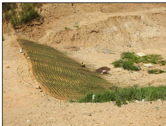
Ilustración 5 Siembra de material vegetal en talud de la celda de respaldo 2.
