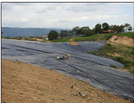
Ilustración 4 Instalación de 5000 m2 de geomembrana en la corona de la celda 4.
