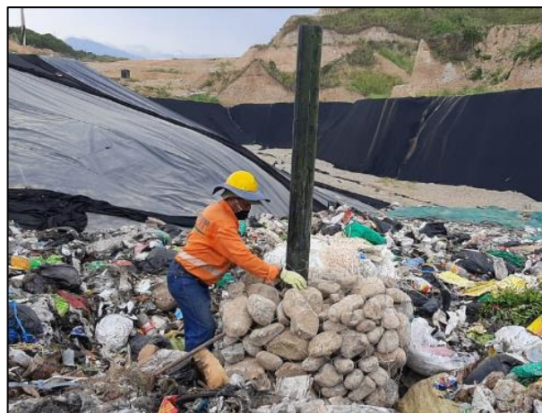
Ilustración 11 Realce de chimeneas celda de respaldo 2.
