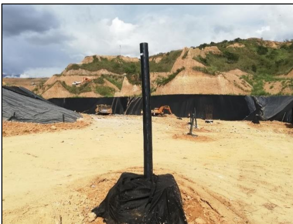
Ilustración 10 Realce de chimeneas celda de respaldo 2.
