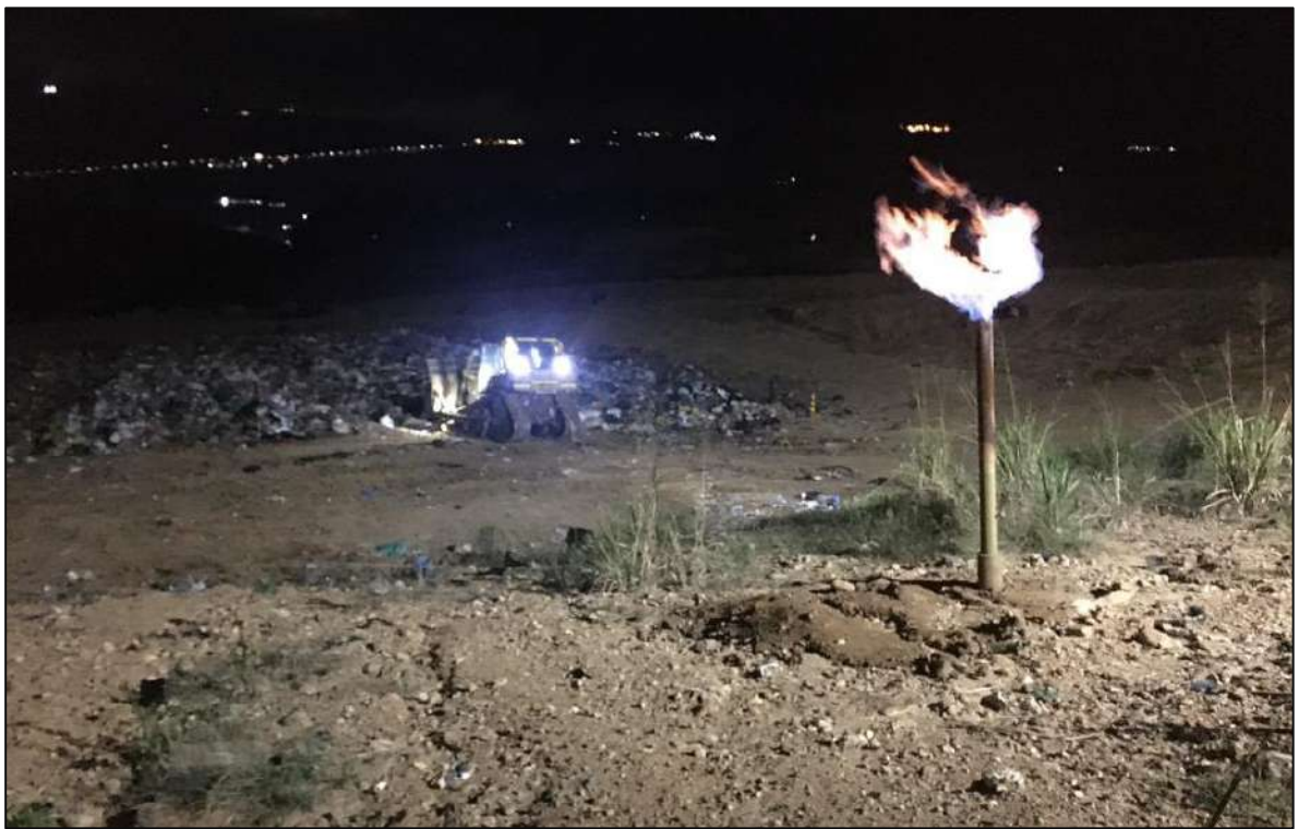
Ilustración 17 Verificación de chimeneas encendidas en el recorrido nocturno
