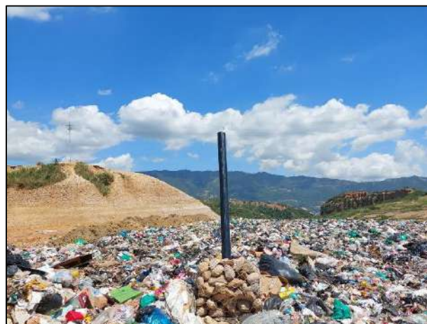
Ilustración 19 Realce de chimeneas celda actual de disposición
