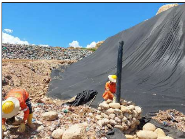
Ilustración 68 Realce de chimeneas celda actual de disposición
