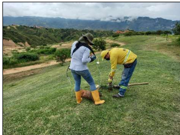
Ilustración 22 Caracterización de biogás celda 1 parte alta domo
