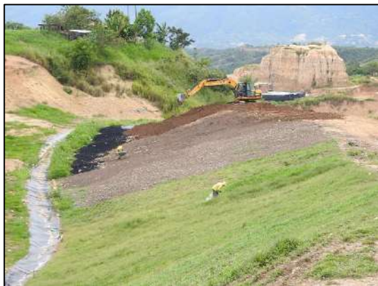
Ilustración 6 Instalación capa orgánica y material vegetal en los 2175 m 2 de geocelda en el talud de la celda 4
