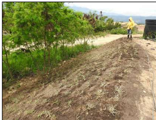
Ilustración 7 Siembra de material vegetal en el talud norte de la celda 4 (800 m 2 )
