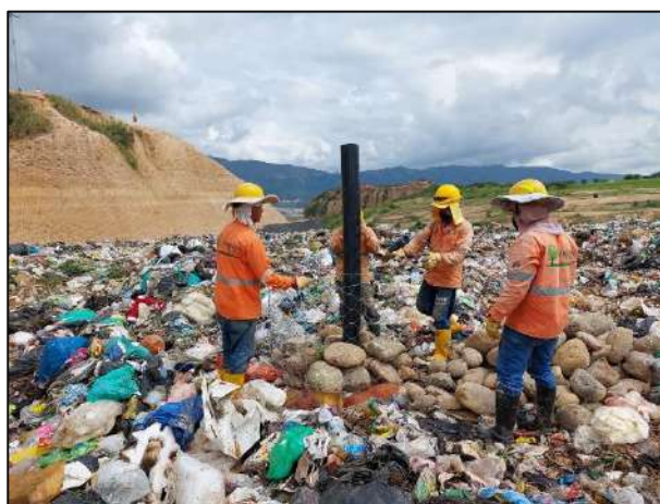
Ilustración 20 Construcción de chimeneas celda actual de disposición.
