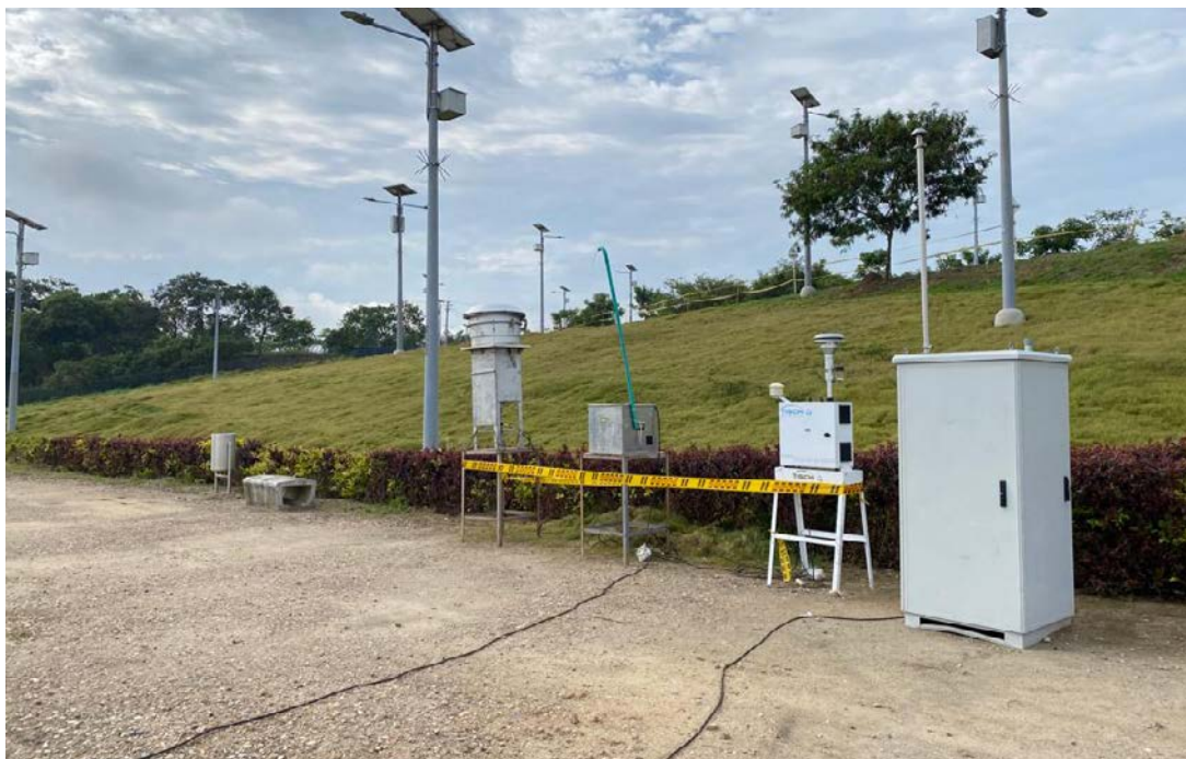
Figura 1 Estación de calidad del aire instalada en el Parque Contemplativo durante la campaña de 2022.
