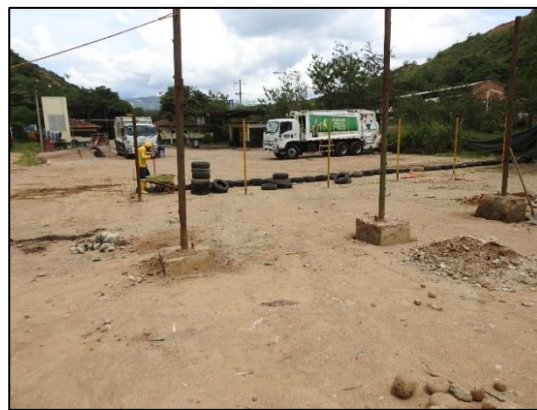
Ilustración 19 Obras de ampliación en el área de vivero
