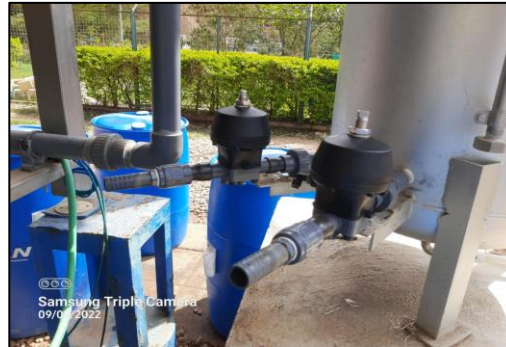
Ilustración 41 Instalación válvulas neumáticas nuevas para control del flujo de salida del calderín
