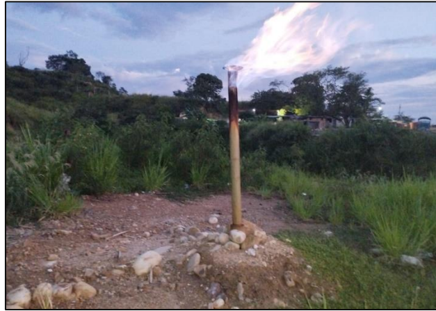
Ilustración 24 Verificación de chimeneas encendidas en el recorrido nocturno.
