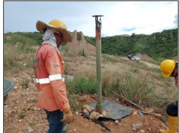
Ilustración 28 Realce de chimeneas celda actual de disposición.
