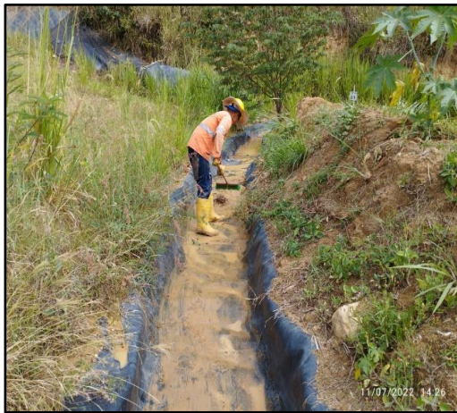
Ilustración 10 Construcción del sistema para manejo de aguas lluvias
