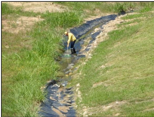
Ilustración 14 Limpieza de canales de aguas lluvias en zonas clausuradas
