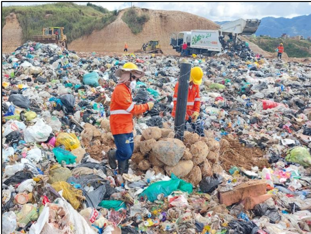
Ilustración 25 Realce de chimeneas celda actual de disposición.
