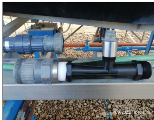
Ilustración 42 Instalación de un venturi nuevo en el circuito de recirculación DAF
