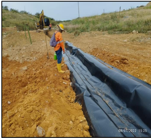
Ilustración 10 Construcción del sistema para manejo de aguas lluvias
