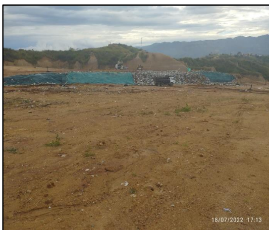
Ilustración 7 Cobertura de residuos sólidos con lona sintética.
