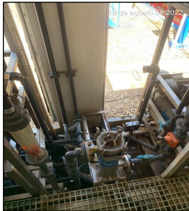
Ilustración 40 Instalación de una nueva unidad de microfiltración de cartuchos en la DTRO
