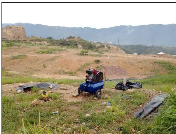
Ilustración 38 Extracción forzada celda de contingencia PEF 15.
