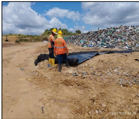
Ilustración 9 Construcción subdrenes para manejo de lixiviados
