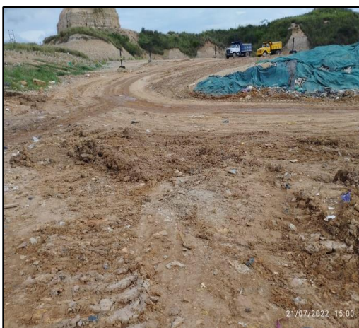
Ilustración 7 Cobertura de residuos sólidos con lona sintética.
