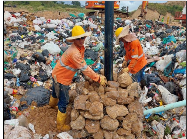
Ilustración 26 Realce de chimeneas celda actual de disposición.
