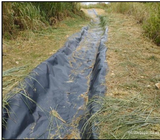
Ilustración 10 Construcción del sistema para manejo de aguas lluvias
