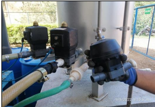
Ilustración 41 Instalación válvulas neumáticas nuevas para control del flujo de salida del calderín
