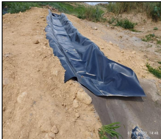
Ilustración 9 Construcción subdrenes para manejo de lixiviados
