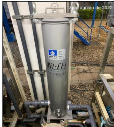
Ilustración 40 Instalación de una nueva unidad de microfiltración de cartuchos en la DTRO
