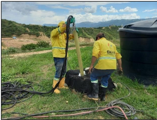
Ilustración 36 Extracción forzada celda de contingencia PEF 15.
