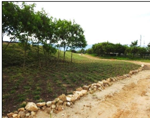
Ilustración 15 Siembra de gramíneas en parte baja del talud norte de la celda 4
