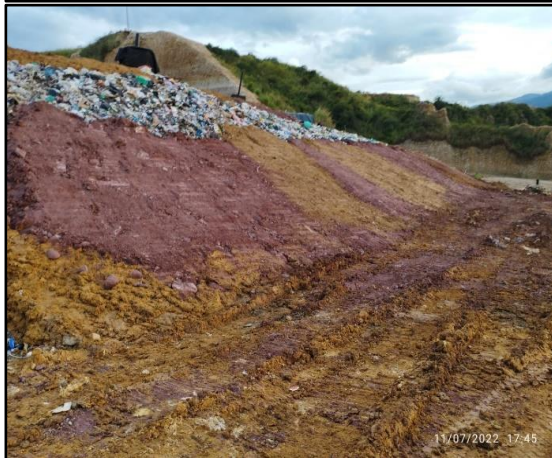
Ilustración 8 Cobertura de residuos sólidos con material terroso o granular.
