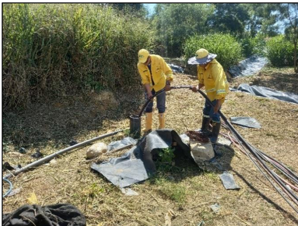
Ilustración 37 Extracción forzada celda 3 PEF 16 y PEF 2.
