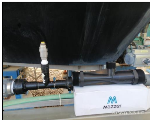
Ilustración 42 Instalación de un venturi nuevo en el circuito de recirculación DAF
