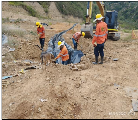
Ilustración 10 Construcción del sistema para manejo de aguas lluvias
