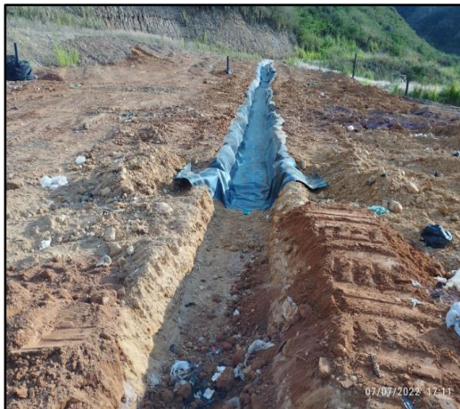
Ilustración 9 Construcción subdrenes para manejo de lixiviados
