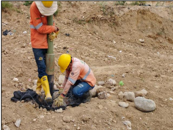
Ilustración 27 Realce de chimeneas celda actual de disposición.
