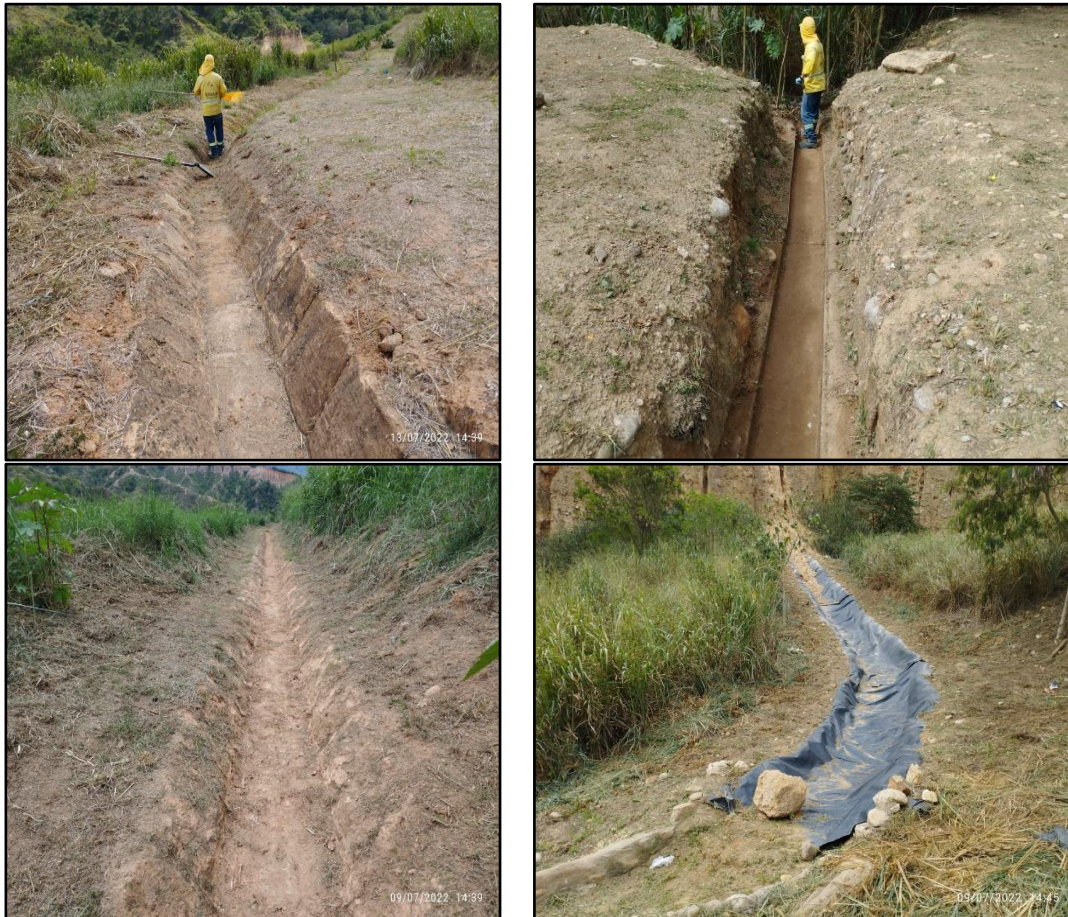
Ilustración 11 Mantenimientos diarios del sistema para manejo de aguas lluvias
