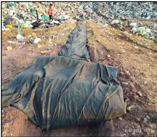
Ilustración 9 Construcción subdrenes para manejo de lixiviados
