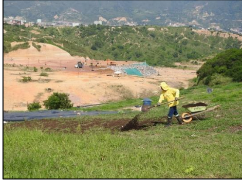
Ilustración 12 Siembra de la cobertura vegetal en los 2125 m2 de geocelda en la celda
