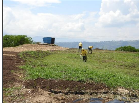
Ilustración 13 Mantenimiento de celdas en proceso de clausura dentro del sitio de disposición final
