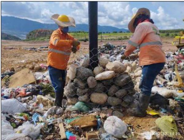
*Ilustración 25 Realce de chimeneas celda actual de disposición.*
