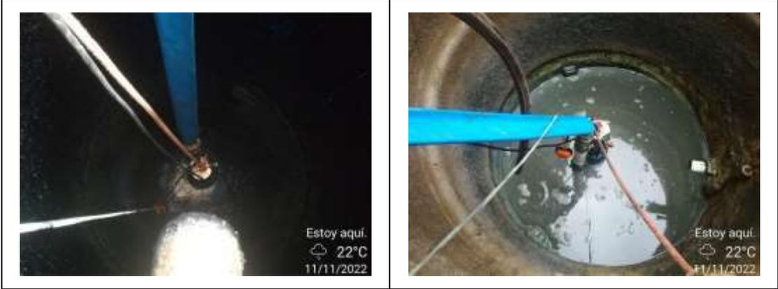
**Registro Fotográfico No. 23.** Limpieza de los tramos de tubería de succión y descarga de la bomba #4 (Bomba del pozo)
