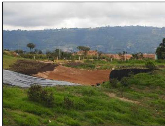
Ilustración 11 Establecimiento de la capa de orgánica en 2700 m2 de geocelda en la celda 4
