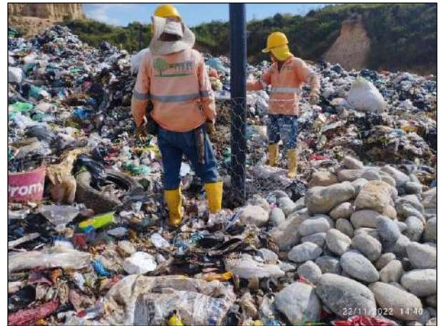
*Ilustración 26 Realce de chimeneas celda actual de disposición.*
