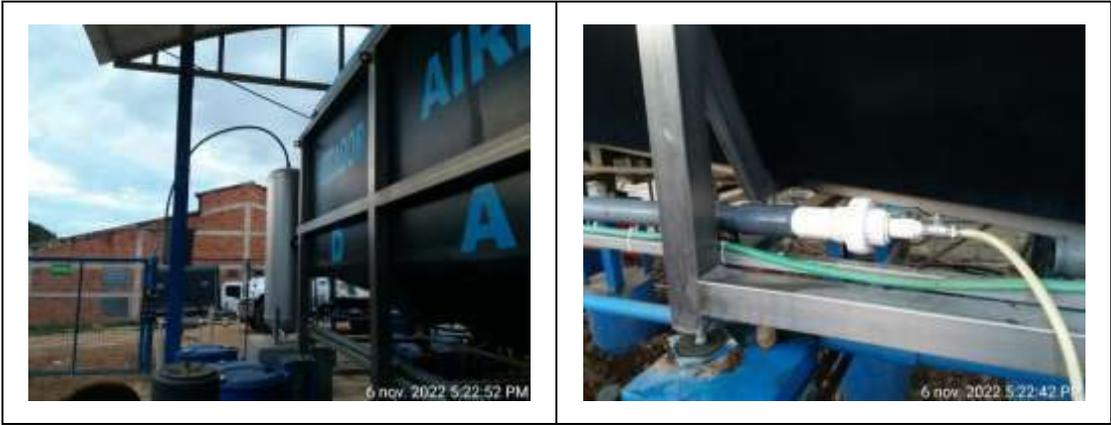
**Registro Fotográfico No. 19.** Reemplazo de la acometida principal y conexión eléctrica de la bomba de recirculación del DAF (Por corrosión de la tornillería)
