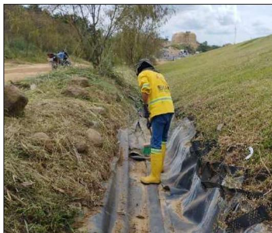
*Ilustración 8 Limpieza de los canales de aguas lluvias*
