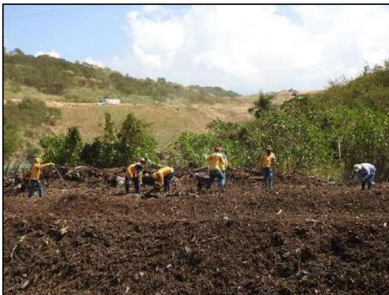
*Ilustración 43 Separación de la fracción vegetal (troncos) del material de podas y rocería*
