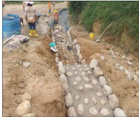
En cuanto a la consolidación de nuevos sistemas de manejo de aguas de escorrentía para el último trimestre de 2022, la EMAB S.A E.S.P., continuó realizando la construcción de canales para la conducción de aguas de escorrentía en saco-tierra, por el borde de la vía principal que comunica en la Zona Clausurada de la cárcava 1, permitiendo de esta manera la captación de las aguas lluvias y su flujo normal sobre el canal, evitando de esta manera que se genere el empozamiento de las mismas.
