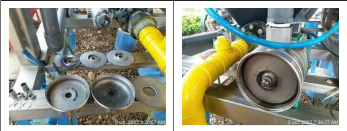
**Registro Fotográfico No. 12.** Recarga de antiescalante usado en la DTRO (Evita que las sales del lixiviado precipiten al interior de las tuberías)
