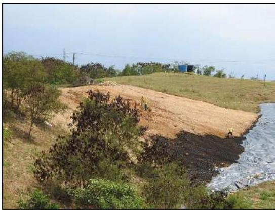
Ilustración 10 Establecimiento de la capa de infiltración en 2700 m2 de geocelda en la celda 4
