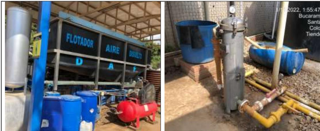
**Registro Fotográfico No. 29.** Estado actual de tanques de almacenamiento, bombas para movimiento de lixiviado, lodos y agua tratada
