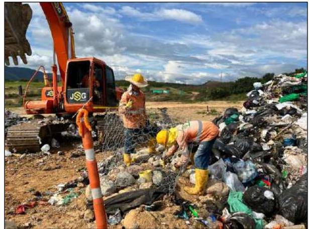
Ilustración 28 Realce de chimeneas celda actual de disposición.
