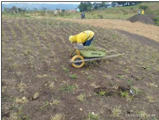
Ilustración 12 Siembra de gramíneas en el talud de la celda 4
