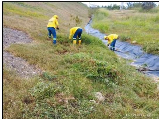
Ilustración 13 Limpieza y deshierbe de canales de aguas lluvias en zonas clausuradas
