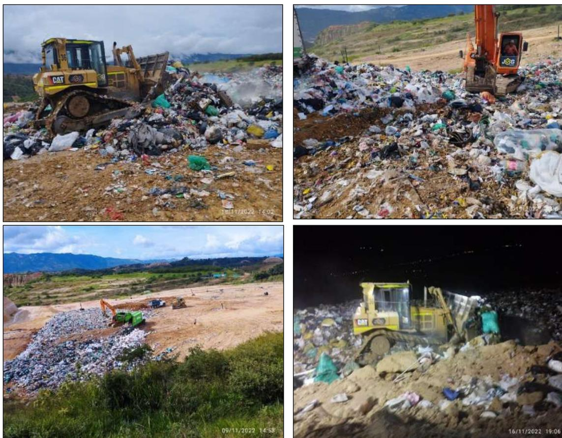
*Ilustración 2 Disgregación y compactación de residuos sólidos en la celda actual*
