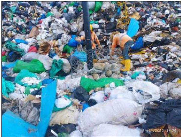
Ilustración 27 Realce de chimeneas celda actual de disposición.
