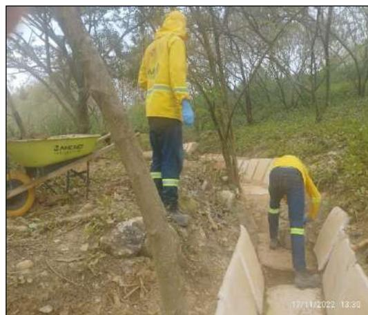
*Ilustración 7 Construcción de canales en saco-tierra*
