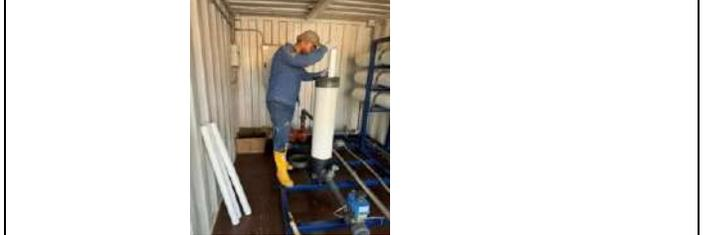
Cambio cartuchos de microfiltración y mantenimiento de las membranas de la OR
