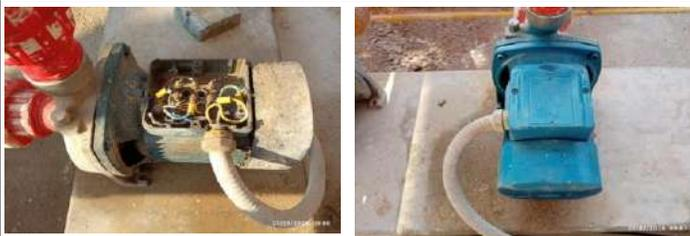
Reemplazo bomba de concentrados por falla eléctrica
