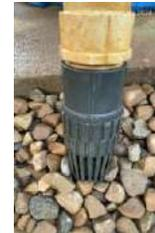
Inspección y limpieza del pie de válvula de la bomba del pozo, tanque alimentación y salida DAF
