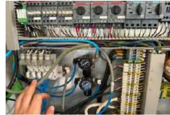
Reemplazo manguera neumática en el tablero del DAF
