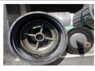
Reemplazo de la válvula de retención ubicada en el circuito de recirculación del DAF
