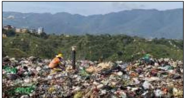
*Ilustración. Realce y construcción de chimeneas celda actual de disposición.*
