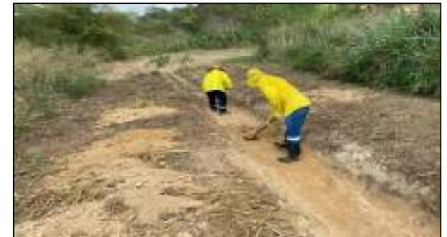
*Ilustración. Limpieza de los canales de aguas lluvias, 2024*
