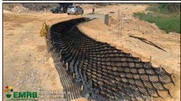
Ilustración. Construcción canales para manejo de aguas lluvias y escorrentía, febrero de 2024
