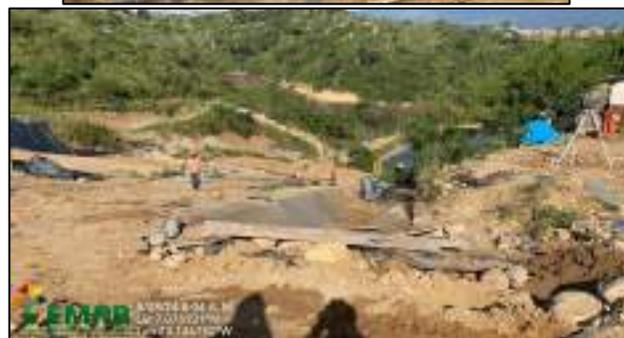
*Ilustración. Mantenimiento canal en geomembrana HDPE cal. 40 mils, agosto 2024*
