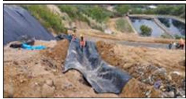
*Ilustración. Construcción canal con geocelda N°.3 y canal superficial con geomembrana HDPE calibre 40 mils, abril 2024*
