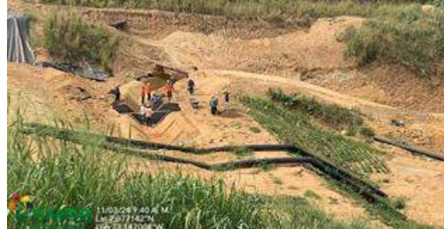
*Construcción de Canales en geomembrana sobre el costado sur de la celda de respaldo 1*
