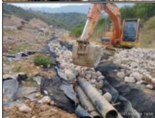
*Ilustración. construcción de sistemas de drenaje de lixiviados, febrero 2024*
