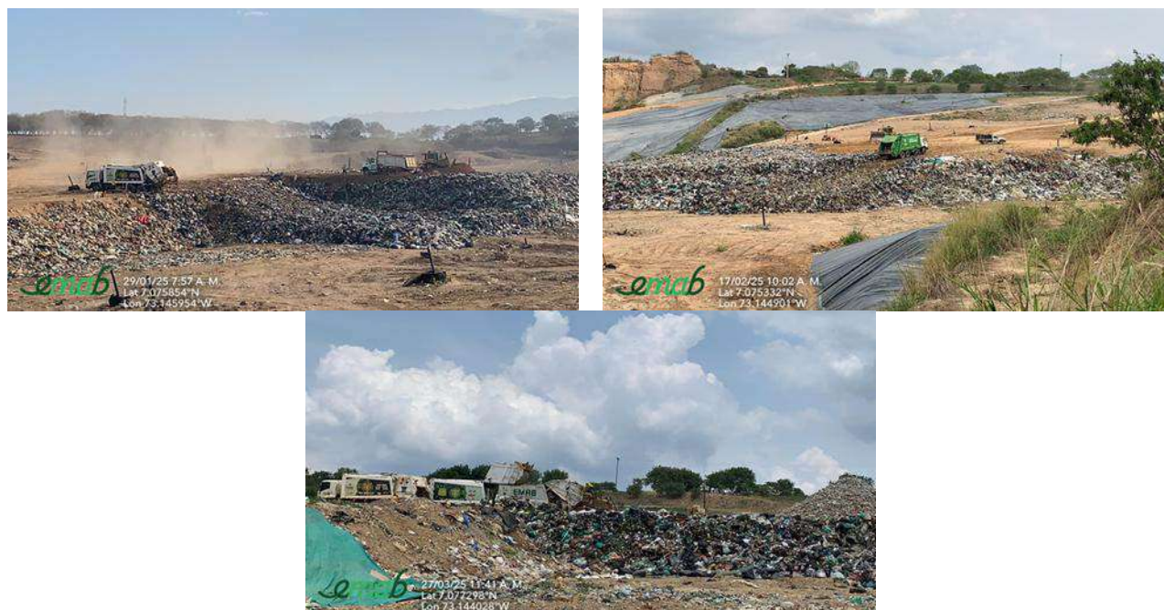
Ilustración 1 Disgregación y compactación de residuos sólidos en la celda actual, primer trimestre 2025
