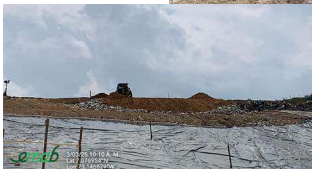
Ilustración 2 Cobertura de residuos sólidos con lona sintética y con material terroso o granular, primer trimestre 2025
