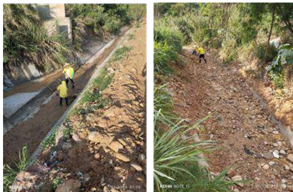
Ilustración 4 Limpieza de los canales de aguas lluvias, primer trimestre 2025
