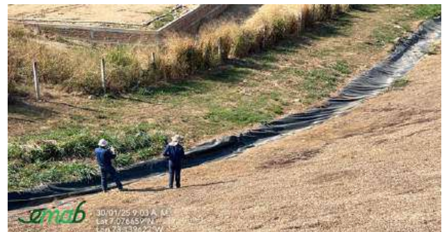
EM4- Canal celda 4 vía malpaso
