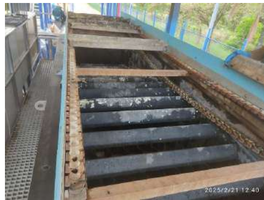
Reemplazo de la cadena del DAF
