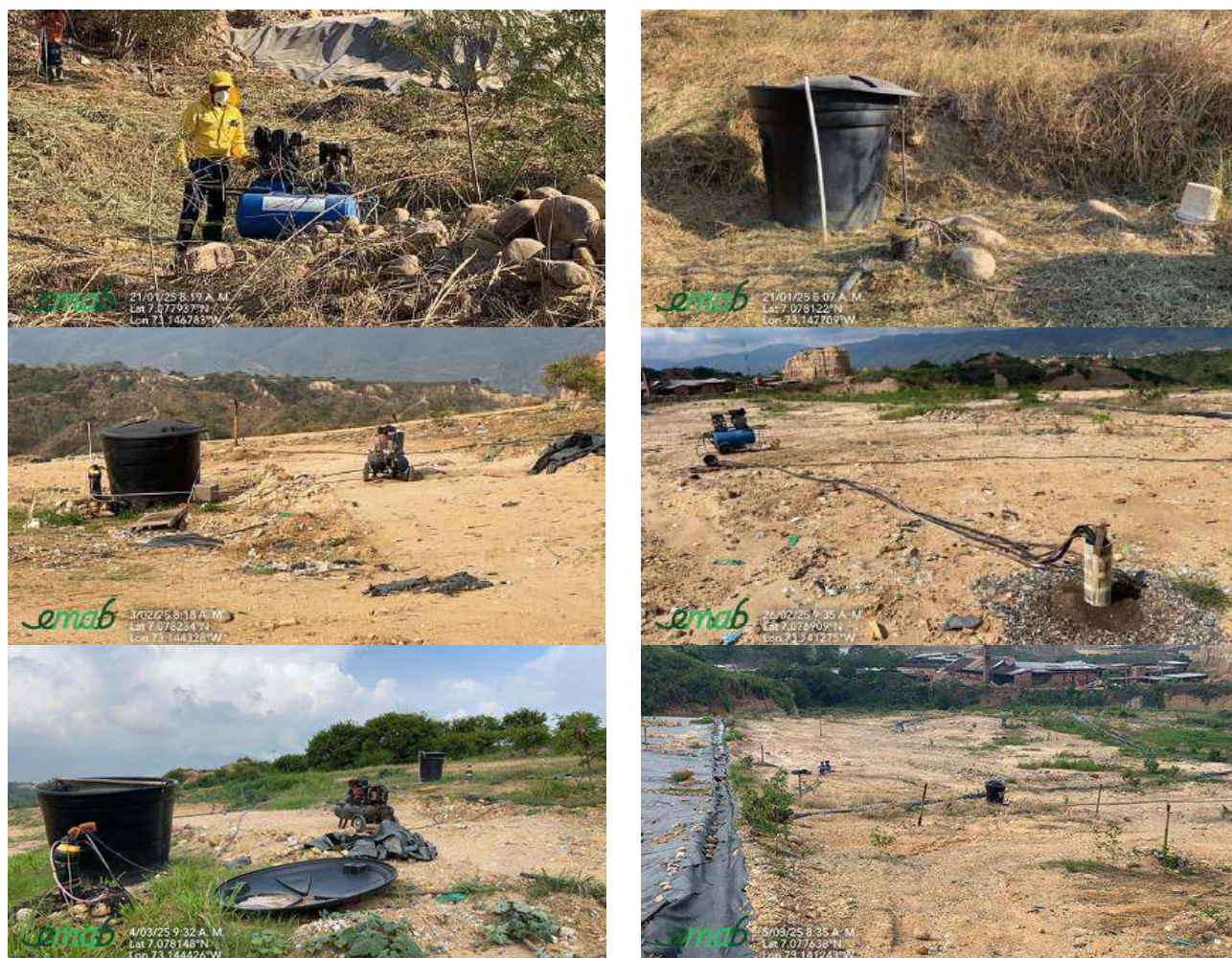
Ilustración 18 Actividades de extracción forzada de lixiviados, 2025
