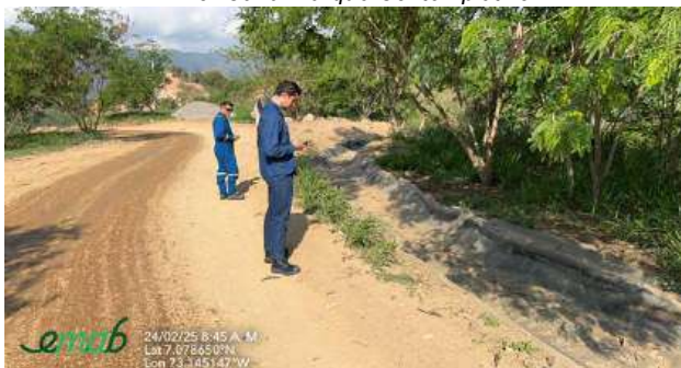
EM5- Canal Celda 1 parte alta
