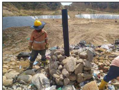
Ilustración 10 Realce y construcción de chimeneas celda actual de disposición.
