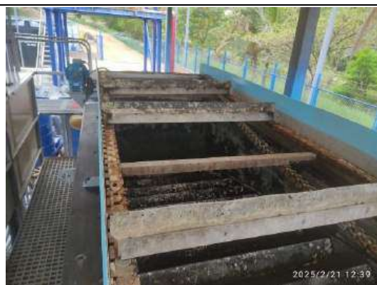
Reemplazo de la cadena del DAF
