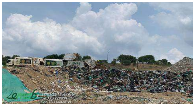
Ilustración Disgregación y compactación de residuos sólidos en la celda actual, primer trimestre 2025
