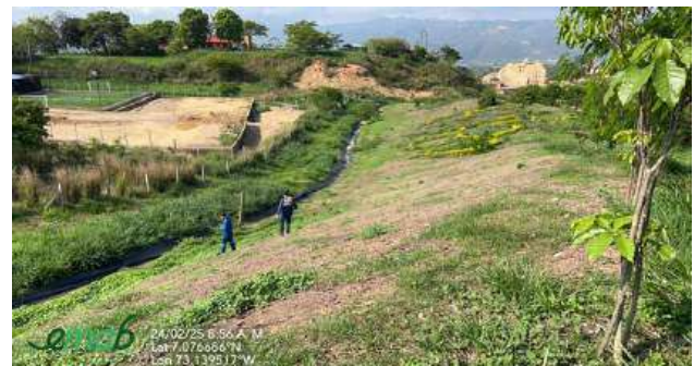
EM4- Canal celda 4 vía malpaso
