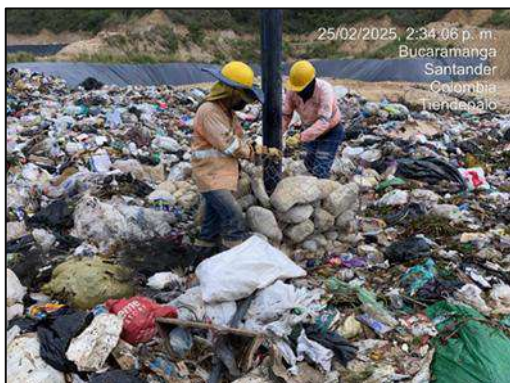
Ilustración 10 Realce y construcción de chimeneas celda actual de disposición.
