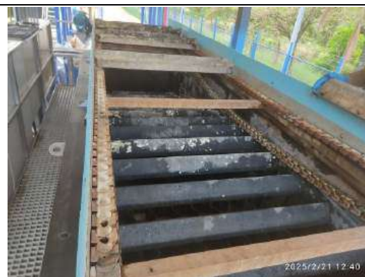
Reemplazo de la cadena del DAF
