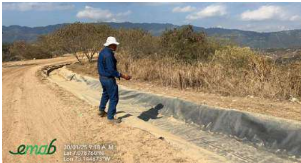
EM5- Canal Celda 1 parte alta
