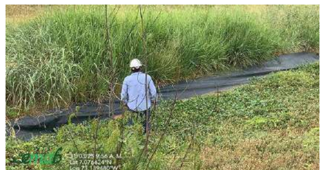
EM4- Canal celda 4 vía malpaso
