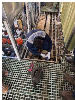
Mantenimiento preventivo de la bomba de alta presión de la DTRO
