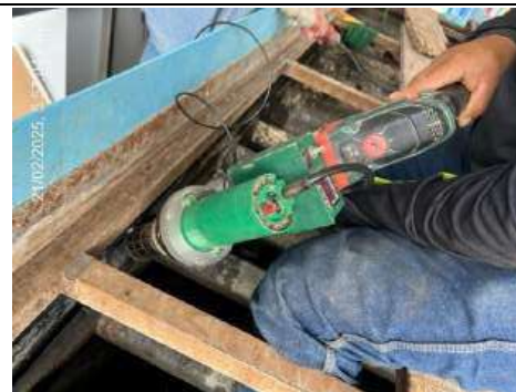
Mantenimiento del espesador estático de lodo en la celda de flotación DAF
