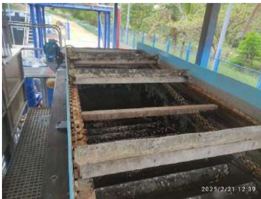
Reemplazo de la cadena del DAF
