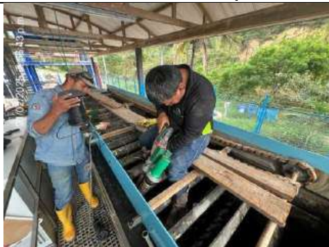
Mantenimiento del espesador estático de lodo en la celda de flotación DAF
