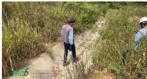
EM8- Canal 2 – Costado sur Etapa 1 parte baja
