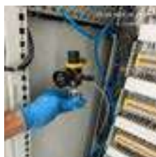
Instalación estación de mantenimiento neumático en la DTRO y reemplazo de una electroválvula
