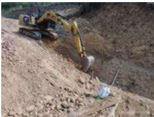
Construcción canales para manejo de aguas lluvias y de escorrentía en la Zona 1 Cárcava 1, zona 2 cárcava 1 y celda 4
