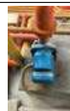
Reemplazo bomba BR7 por la bomba BR6 en posición B7-Falla del sello mecánico
