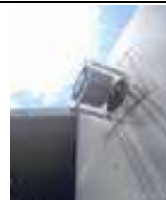
Reemplazo de los extractores del contenedor de la DTRO
