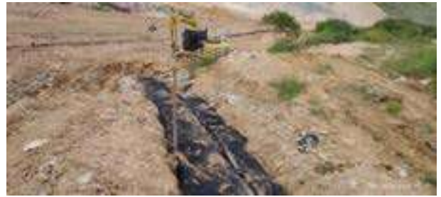
Ilustración. Construcción de subdrenes tipo 2 y tipo 3, mayo de 2024
