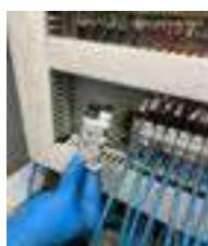
Instalación estación de mantenimiento neumático en la DTRO y reemplazo de una electroválvula
