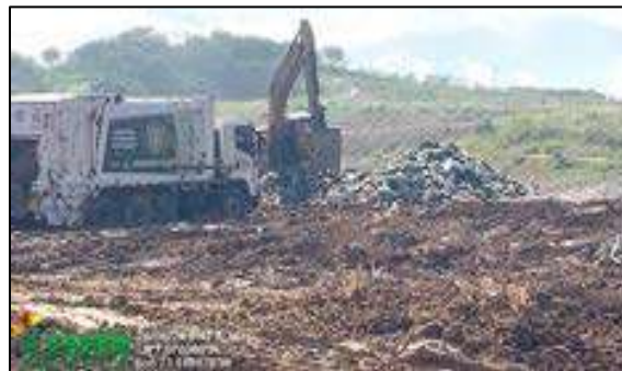
Ilustración. Disgregación y compactación de residuos sólidos en la celda actual
