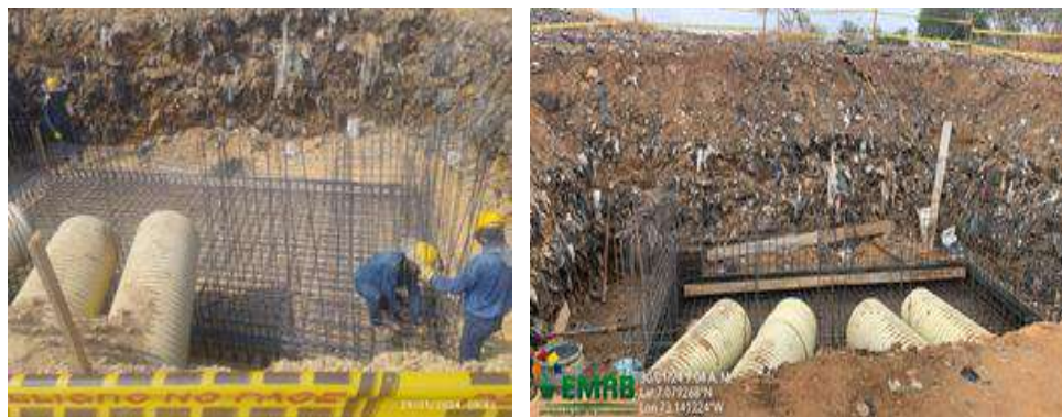
Ilustración 1 Construcción canales para manejo de aguas lluvias y escorrentía, enero de 2024
