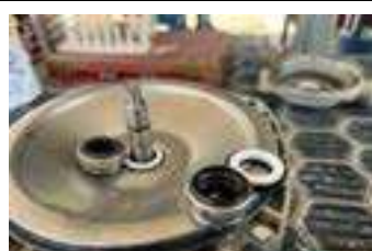
Cambio del sello mecánico de la bomba BR7
