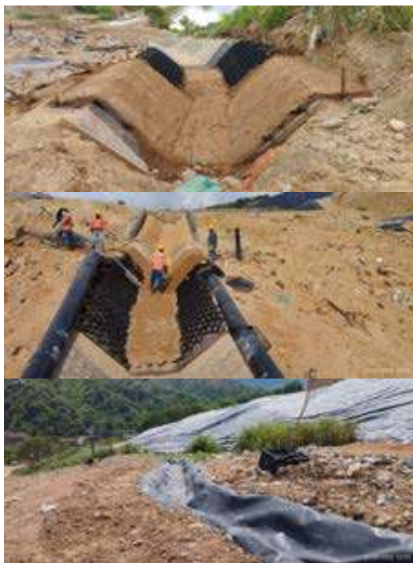
Ilustración. Construcción canal con geocelda N°.1, canal central y canal sup. con geomembrana HDPE cal. 40 mils, mayo 2024
