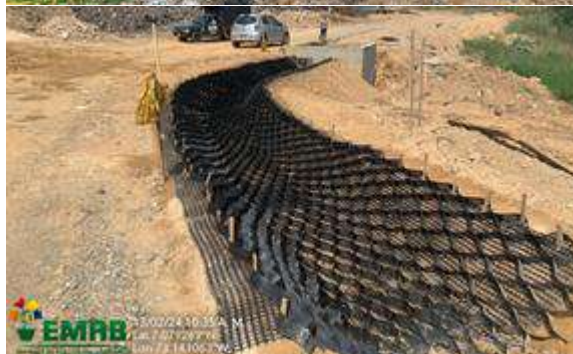
Ilustración 2 Construcción canales para manejo de aguas lluvias y escorrentía, febrero de 2024
