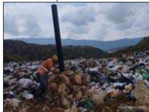
Ilustración. Realce de chimeneas celda actual de disposición.
