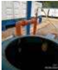
Limpieza del tubo floculador del DAF
