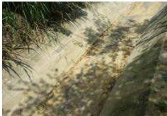
Quebrada El Carrasco – Aguas Abajo
