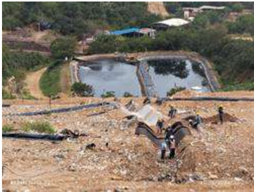
Ilustración. Construcción canal central y canal con geocelda N°1, junio de 2024
