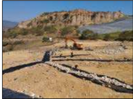
Ilustración. construcción de sistemas de drenaje de lixiviados, enero 2024
