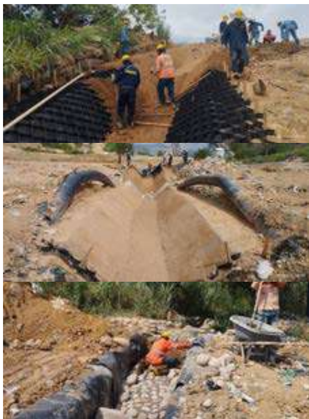
Ilustración. Construcción canal con geocelda N°.1, canal central y canal sup. con geomembrana HDPE cal. 40 mils, mayo 2024
