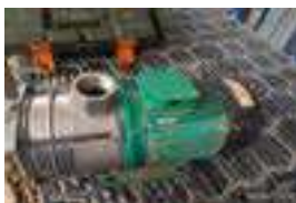
Reemplazo del sello mecánico de la bomba de recirculación DAF
