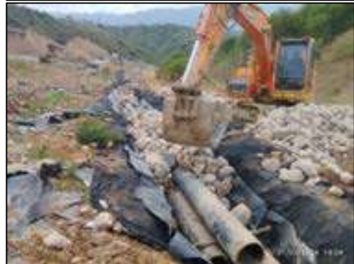
Ilustración. construcción de sistemas de drenaje de lixiviados, febrero 2024
