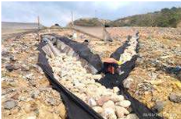
Ilustración. Construcción de sistema de drenaje etapas 1D y 1E, marzo de 2024
