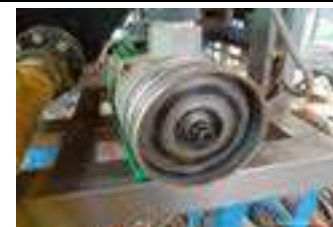
Inspección y mantenimiento de la bomba de recirculación del DAF
