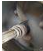
Reemplazo del sello mecánico de la bomba de recirculación DAF
