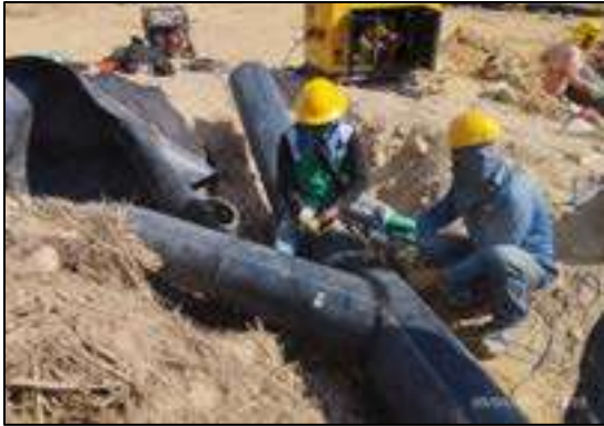
Ilustración. construcción de sistemas de drenaje de lixiviados, enero 2024
