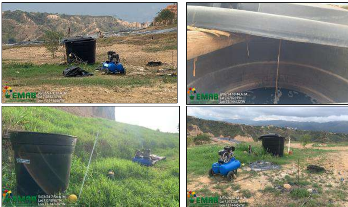
Ilustración. Actividades de extracción forzada de lixiviados
