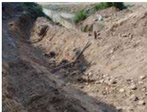
Construcción canales para manejo de aguas lluvias y de escorrentía en la Zona 1 Cárcava 1, zona 2 cárcava 1 y celda 4
