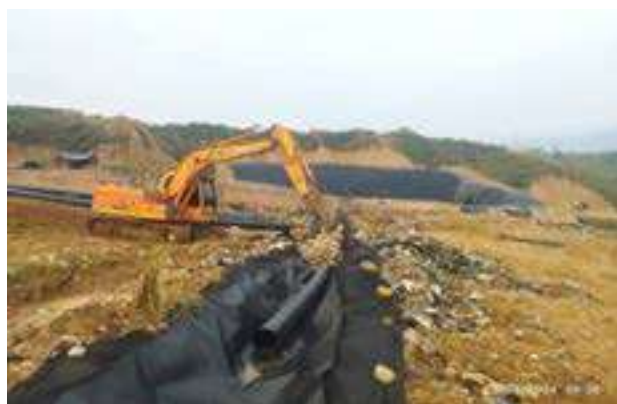
Ilustración. Construcción de sistema de drenaje etapas 1D y 1E, marzo de 2024
