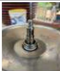
Limpieza del visor del tanque de 20 m3 Alimentación DTRO
