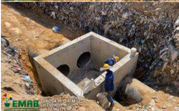
Ilustración 2 Construcción canales para manejo de aguas lluvias y escorrentía, febrero de 2024
