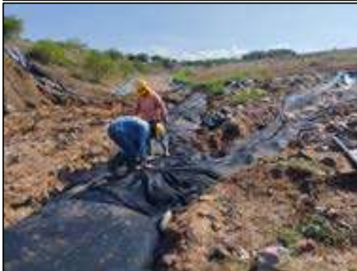
Ilustración. construcción de sistemas de drenaje de lixiviados, febrero 2024
