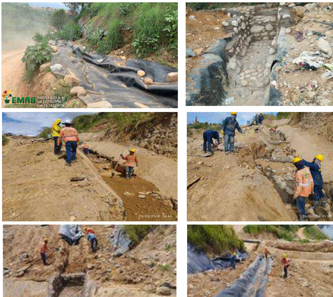
Ilustración. Mantenimiento de canales de aguas lluvias, mayo de 2024
