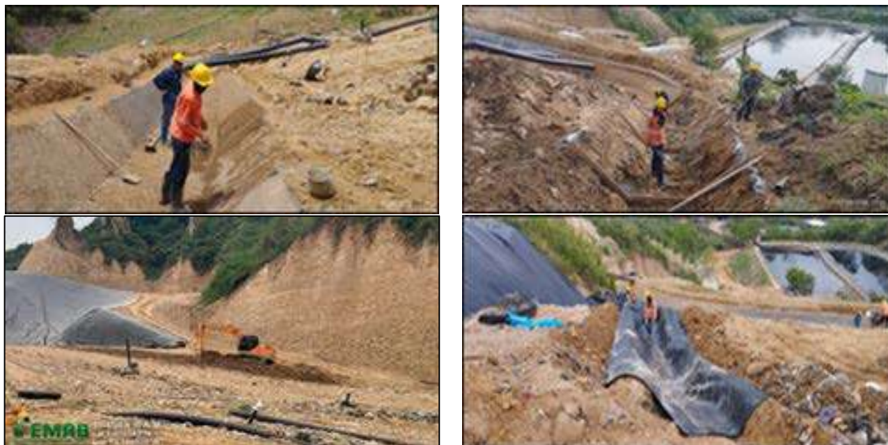
Ilustración. Construcción canal con geocelda N°.3 y canal superficial con geomembrana HDPE calibre 40 mils, abril 2024
