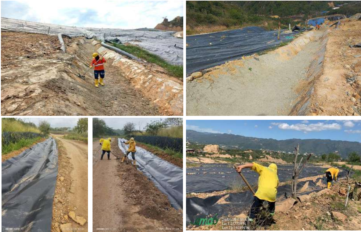
Ilustración Mantenimiento de canales de aguas lluvias, mayo de 2025
