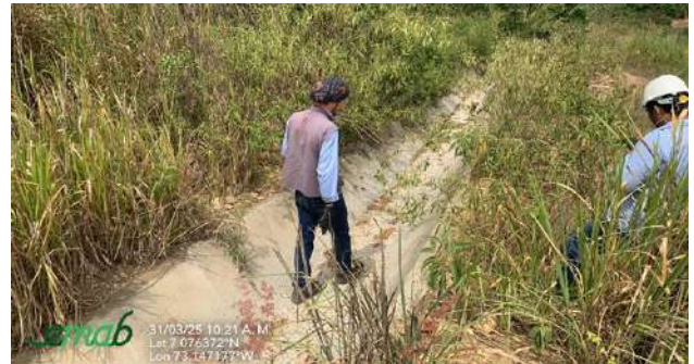
EM8- Canal 2 - Costado sur Etapa 1 parte baja
