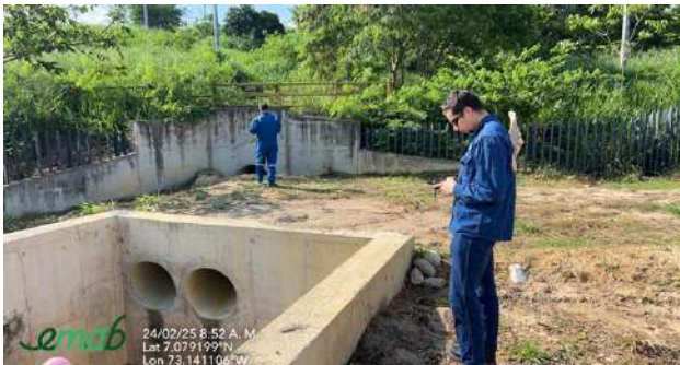
EM3- Canal Parque Contemplativo
