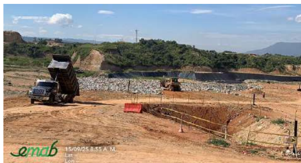
Ilustración Cobertura de residuos sólidos con lona sintética y con material terroso o granular, periodo de enero a septiembre de 2025
