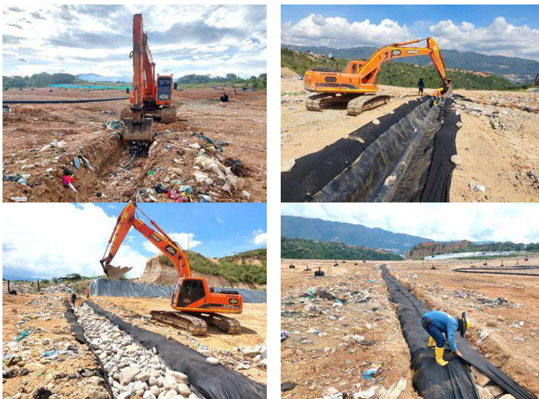
Ilustración Construcción de subdrenes de recolección de lixiviados, agosto 2025
