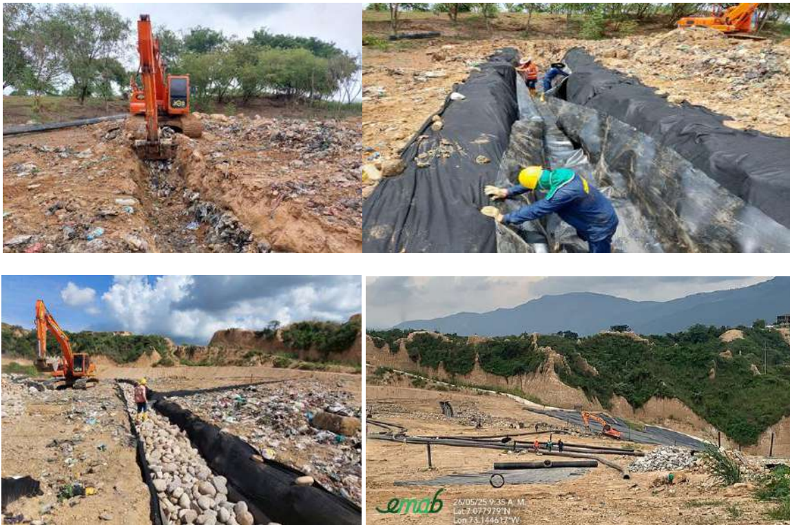
Ilustración Construcción de subdrenes de recolección de lixiviados, mayo 2025
