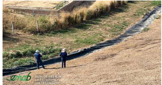
EM4- Canal celda 4 via malpaso
