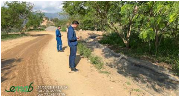
EM5- Canal Celda 1 parte alta
