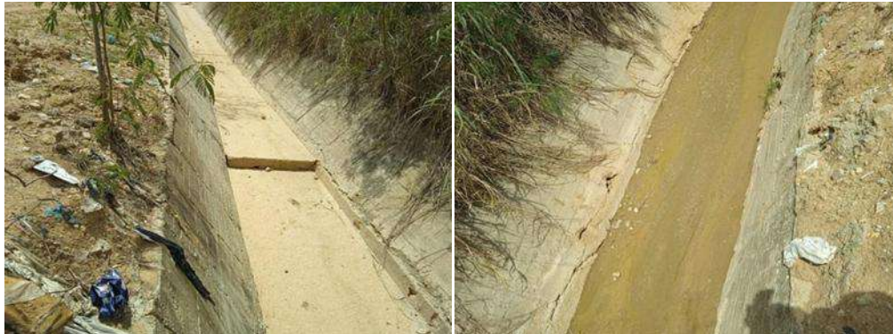
Aguas Arriba Quebrada El Carrasco
