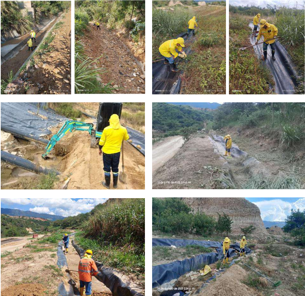
Ilustración Limpieza de los canales de aguas lluvias, enero a septiembre de 2025
