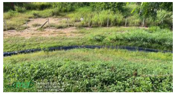
Canal celda 4 via malpaso
