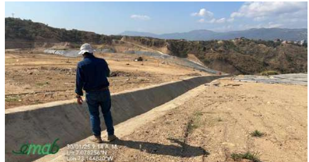
EM7- Canal 1 – Celda de Contingencia
