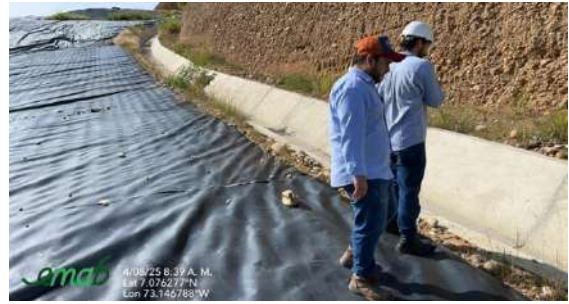
Canal 2 – Zona Sur Etapa 1 parte baja
