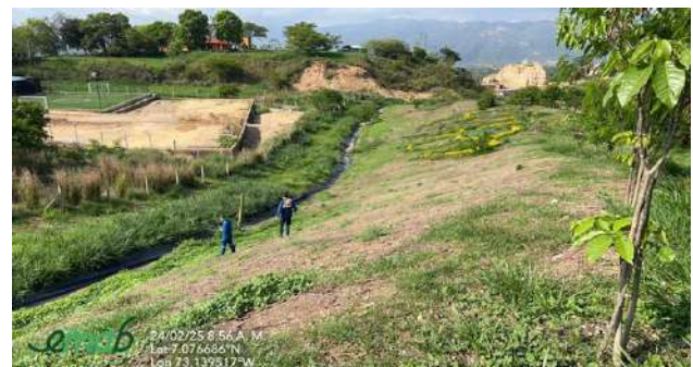
EM4- Canal celda 4 vía malpaso
