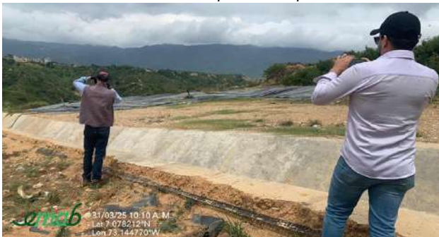
EM7- Canal 1 – Celda de Contingencia
