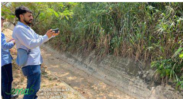
Aguas Arriba Quebrada El Carrasco
