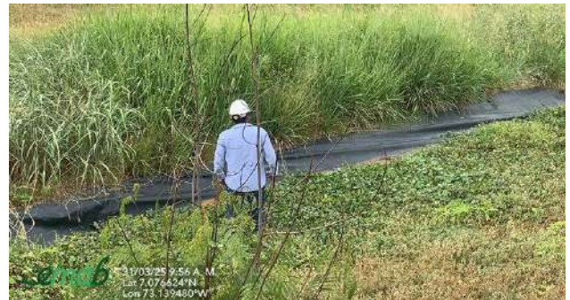
EM4- Canal celda 4 vía malpaso
