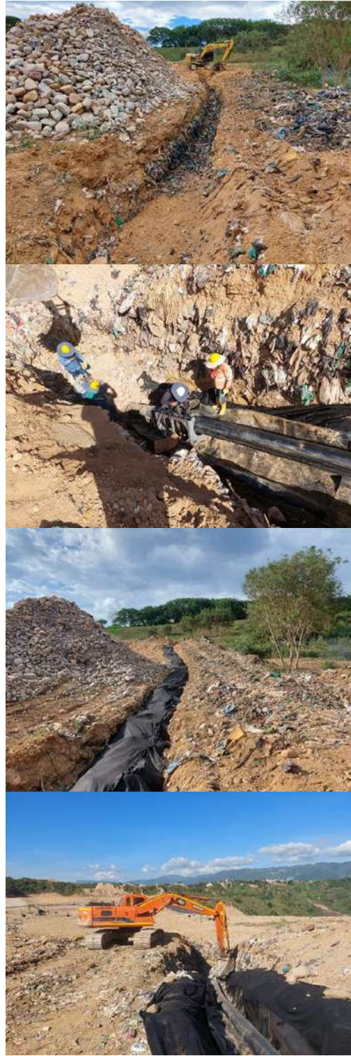
Ilustración Construcción de subdrenes de recolección de lixiviados
