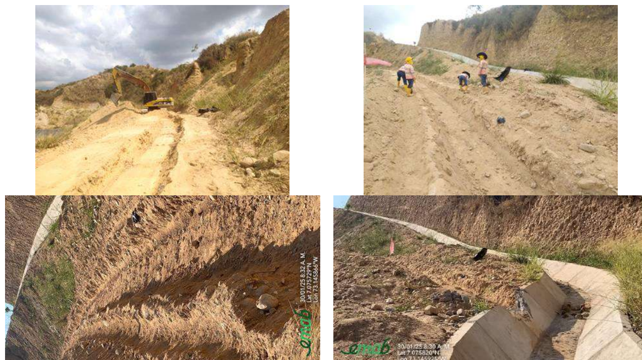
Ilustración Construcción canales para manejo de aguas lluvias y escorrentía, enero de 2025
