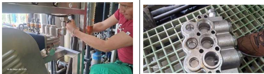
Mantenimiento preventivo de la bomba de pistones de la DTRO
