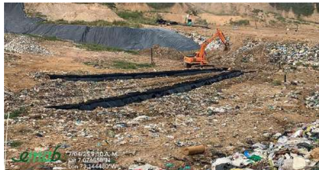
Ilustración Construcción de subdrenes de recolección de lixiviados, abril 2025
