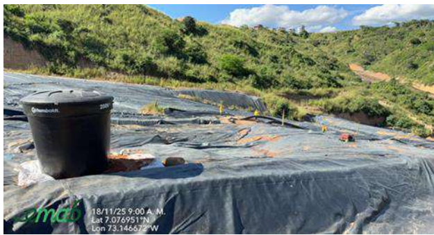
Ilustración Actividades de extracción forzada de lixiviados, enero a septiembre de 2025
