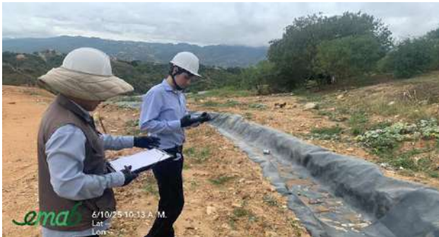
Canal 1 – Celda de Contingencia
