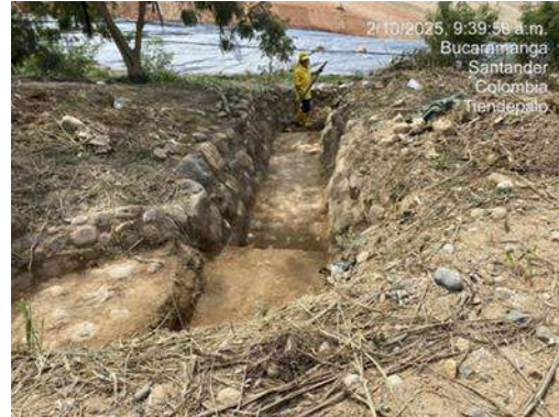
Ilustración Limpieza de los canales de aguas lluvias, enero a diciembre de 2025
