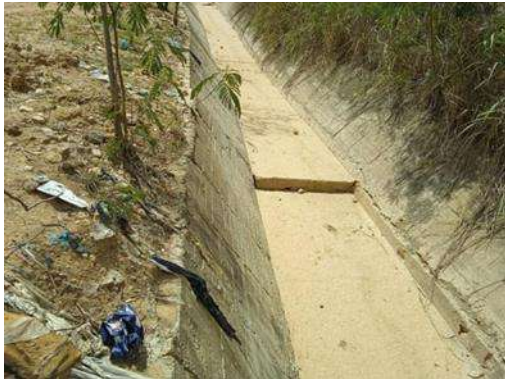
Aguas Arriba Quebrada El Carrasco
