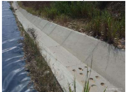
Canal 2 – Zona Sur Etapa 1 parte baja
