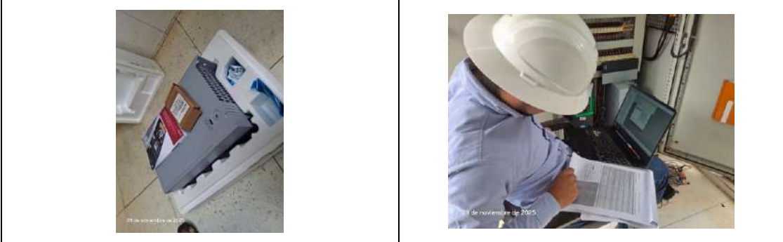
Reactivación de la nueva línea de potencialización de la PTLX
