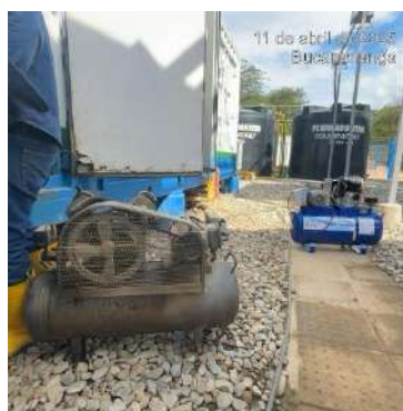
Reemplazo del compresor de aire del sistema DTRO
