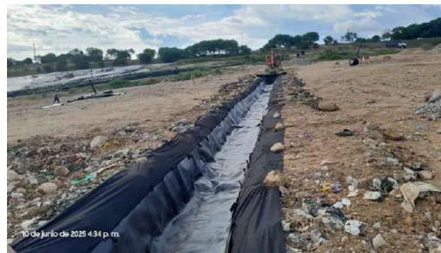
Ilustración Construcción de subdrenes de recolección de lixiviados, junio 2025
