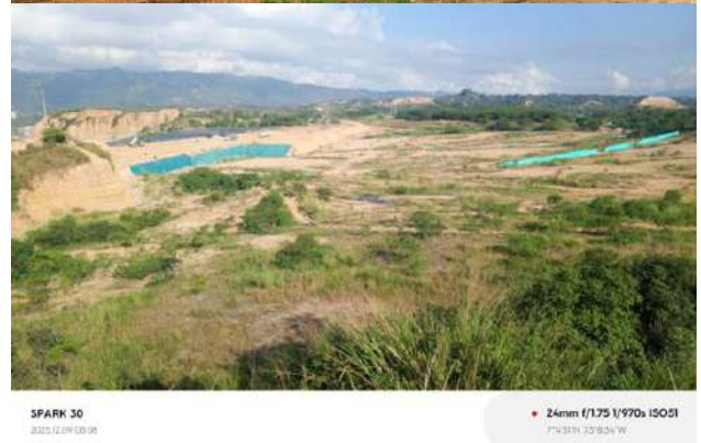
Ilustración Cobertura de residuos sólidos con lona sintética y con material terroso o granular, periodo de enero a diciembre de 2025
