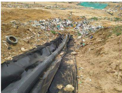
Ilustración Construcción de subdrenes de recolección de lixiviados, marzo 2025
