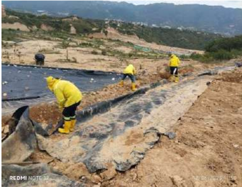
Ilustración Mantenimiento de canales de aguas lluvia y de escorrentía, junio 2025.
