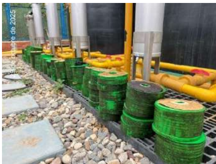
Mantenimiento mayor del sistema DTRO – Sustitución de discos, membranas y vasos de presión
