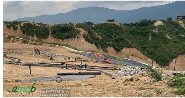
Ilustración Construcción de subdrenes de recolección de lixiviados, mayo 2025
