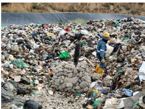
Ilustración Realce y construcción de chimeneas celda actual de disposición, periodo de enero a diciembre 2025
