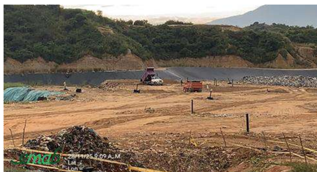
Ilustración Cobertura de residuos sólidos con lona sintética y con material terroso o granular, periodo de enero a diciembre de 2025
