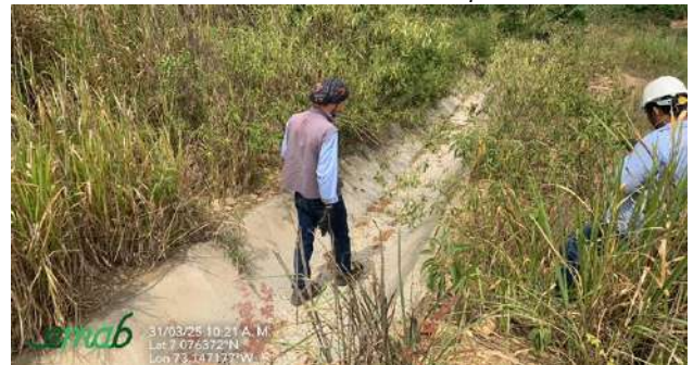
EM8- Canal 2 – Costado sur Etapa 1 parte baja
