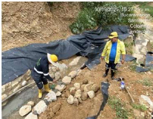
Ilustración Mantenimiento de canales de aguas lluvia y de escorrentía, y canal Quebrada El Carrasco
