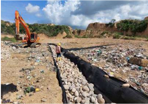
Ilustración Construcción de subdrenes de recolección de lixiviados, mayo 2025
