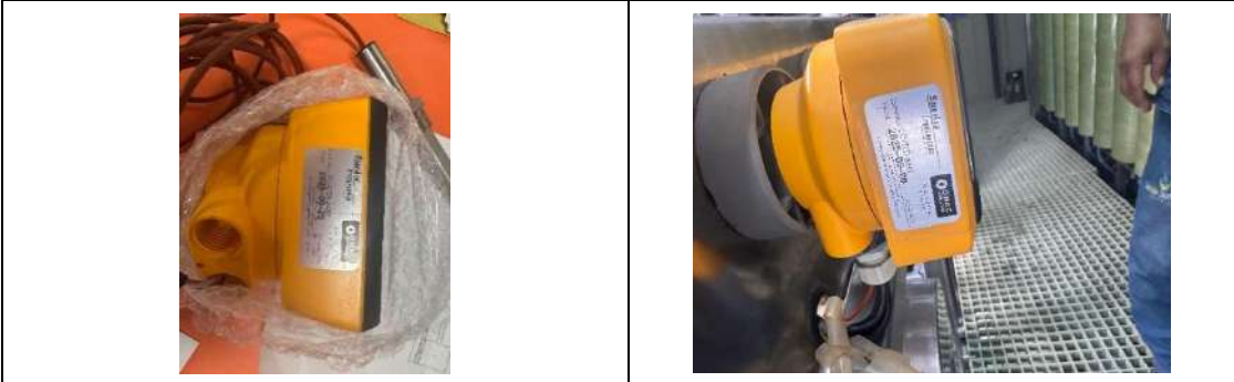
Reemplazo preventivo del variador de frecuencia de la bomba de pistones del sistema DTRO
