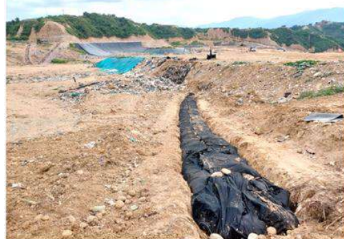
Ilustración Construcción de subdrenes de recolección de lixiviados, marzo 2025
