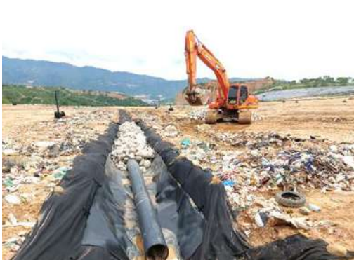
Ilustración Construcción de subdrenes de recolección de lixiviados, junio 2025
