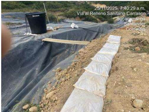
Ilustración Mantenimiento de canales en geomembrana – Celda de Respaldo parte alta, noviembre 2025
