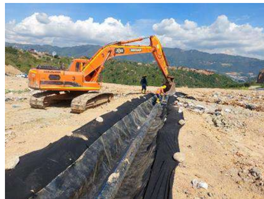
Figura Construcción de subdrenes de recolección de lixiviados, agosto 2025
