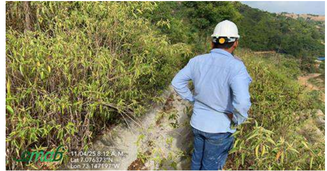
Canal 2 – Zona Sur Etapa 1 parte baja
