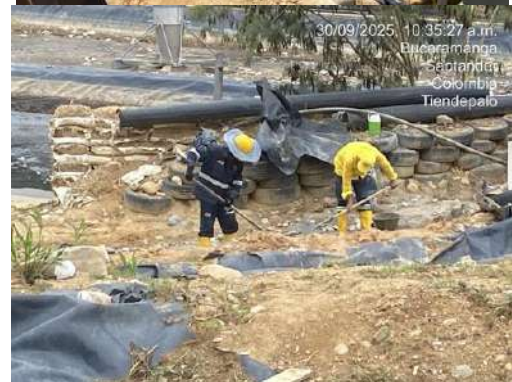
Ilustración Mantenimiento de canales de aguas lluvia y de escorrentía, y canal Quebrada El Carrasco
