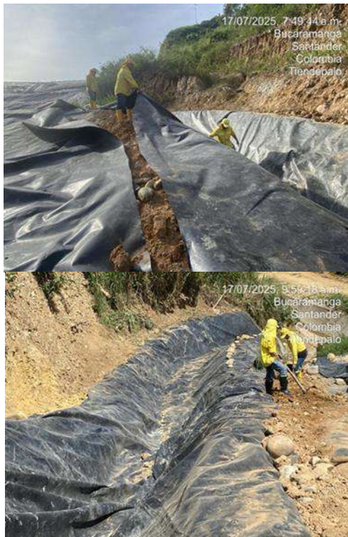
Ilustración Mantenimiento de canales de aguas lluvia y de escorrentía, julio 2025.
