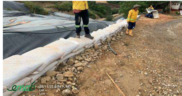
Ilustración Mantenimiento de canales en geomembrana – Celda de Respaldo parte alta, noviembre 2025
