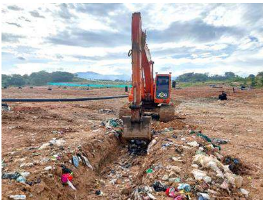
Figura Construcción de subdrenes de recolección de lixiviados, agosto 2025
