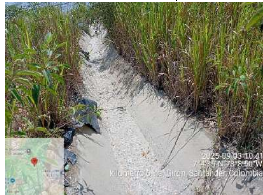
Canal 2 – Zona Sur Etapa 1 parte baja
