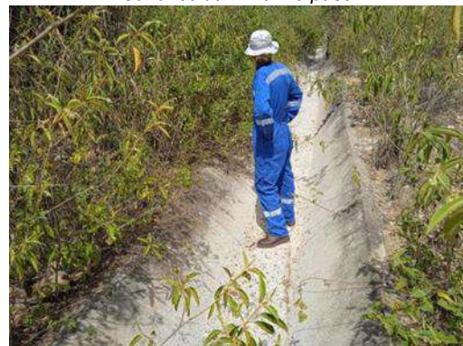
Canal 2 – Zona Sur Etapa 1 parte baja
