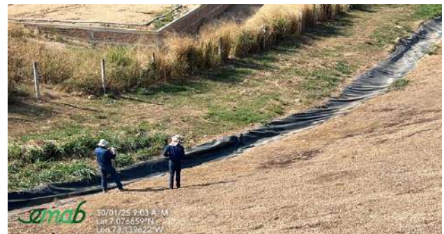
EM4- Canal celda 4 vía malpaso
