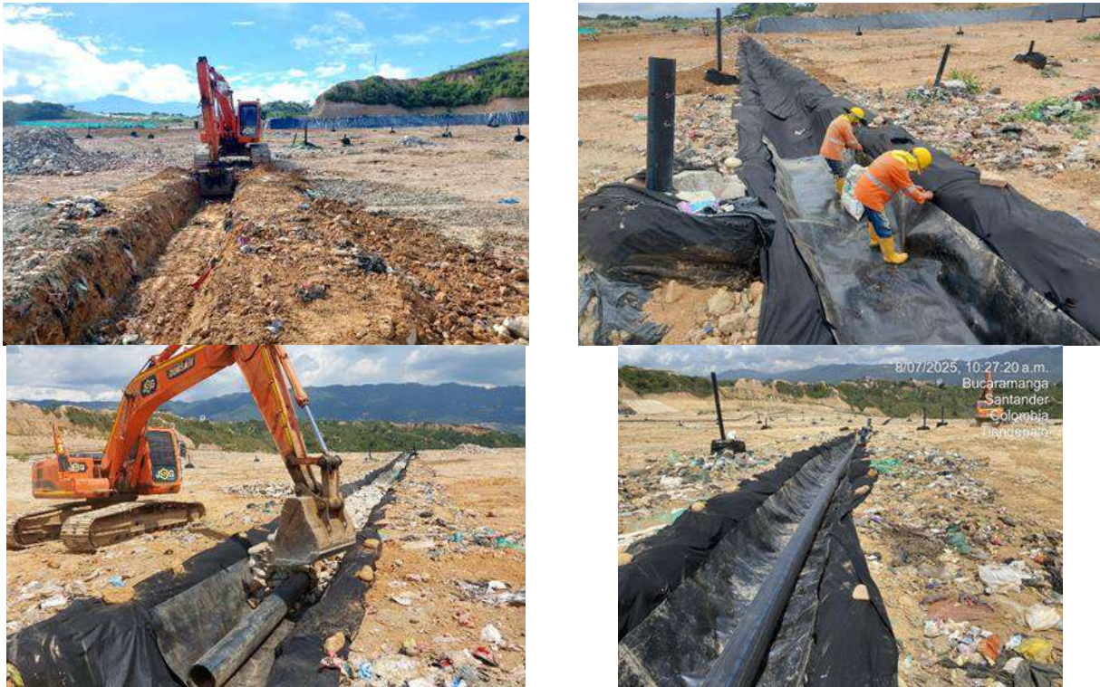
Ilustración Construcción de subdrenes de recolección de lixiviados, julio 2025
