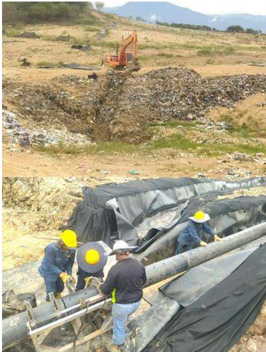
Ilustración Construcción de subdrenes de recolección de lixiviados, abril 2025
