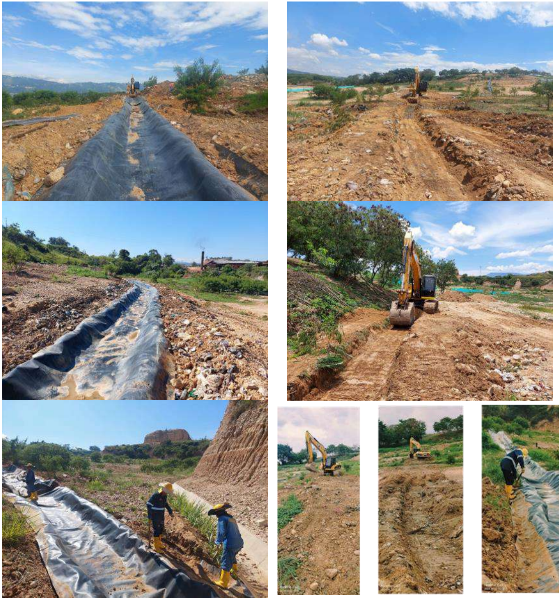
Ilustración Construcción canal superficial para manejo de aguas lluvias en el mes de septiembre de 2025 Consorcio Disposición Final y Seguimiento diario Formato F-GDF-001 – EMAB S.A E.S.P., septiembre 2025
