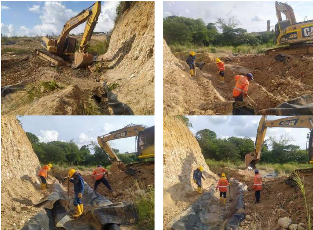
Ilustración Construcción canal de aguas lluvias, marzo de 2025
