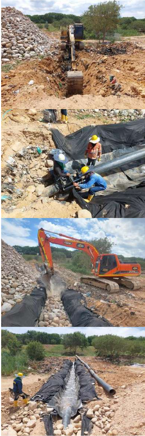
Ilustración Construcción de subdrenes de recolección de lixiviados
