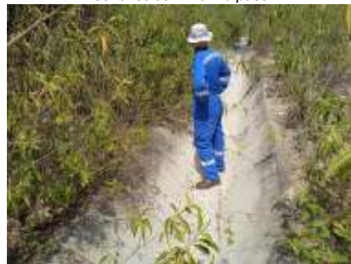
Canal 2 – Zona Sur Etapa 1 parte baja
