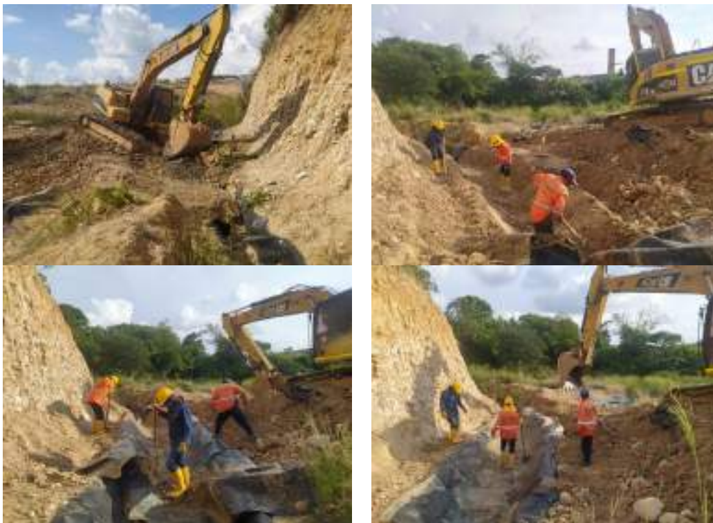
Ilustración 4 Construcción canal de aguas lluvias, marzo de 2025
