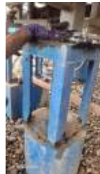
Reemplazo de soportes metálicos del DAF
