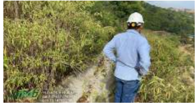
Canal 2 – Zona Sur Etapa 1 parte baja
