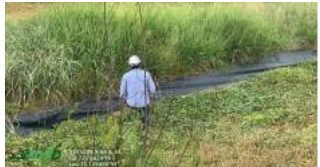
EM4- Canal celda 4 vía malpaso
