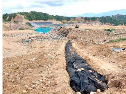
Ilustración 9 Construcción de subdrenes de recolección de lixiviados, marzo 2025
