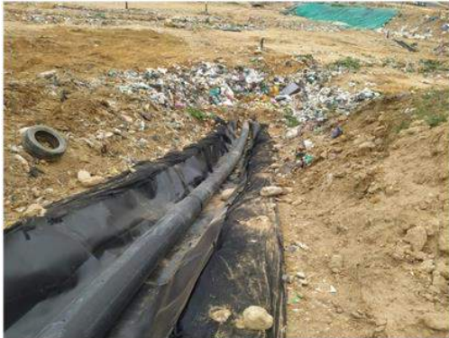
Ilustración 9 Construcción de subdrenes de recolección de lixiviados, marzo 2025
