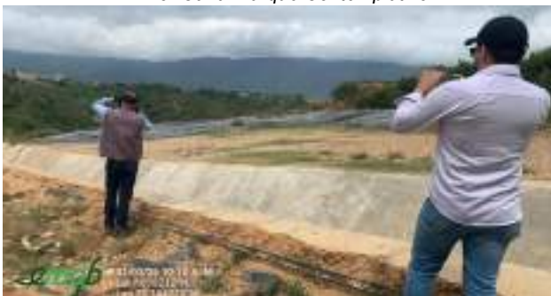
EM7- Canal 1 – Celda de Contingencia
