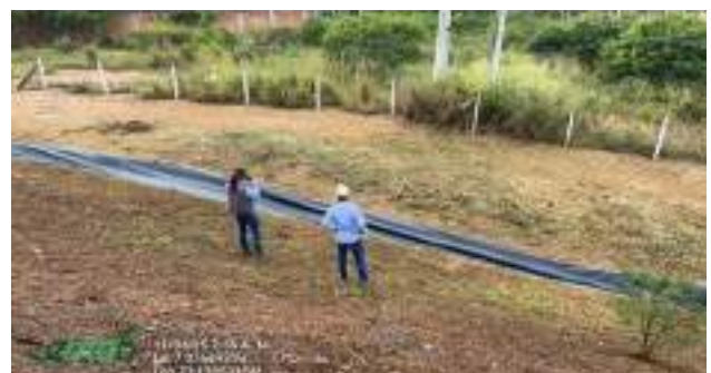
Canal celda 4 vía malpaso
