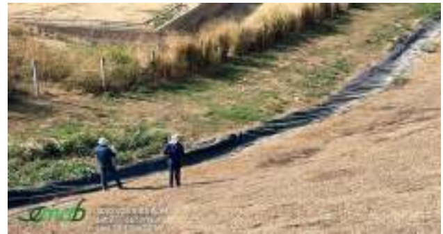
EM4- Canal celda 4 vía malpaso
