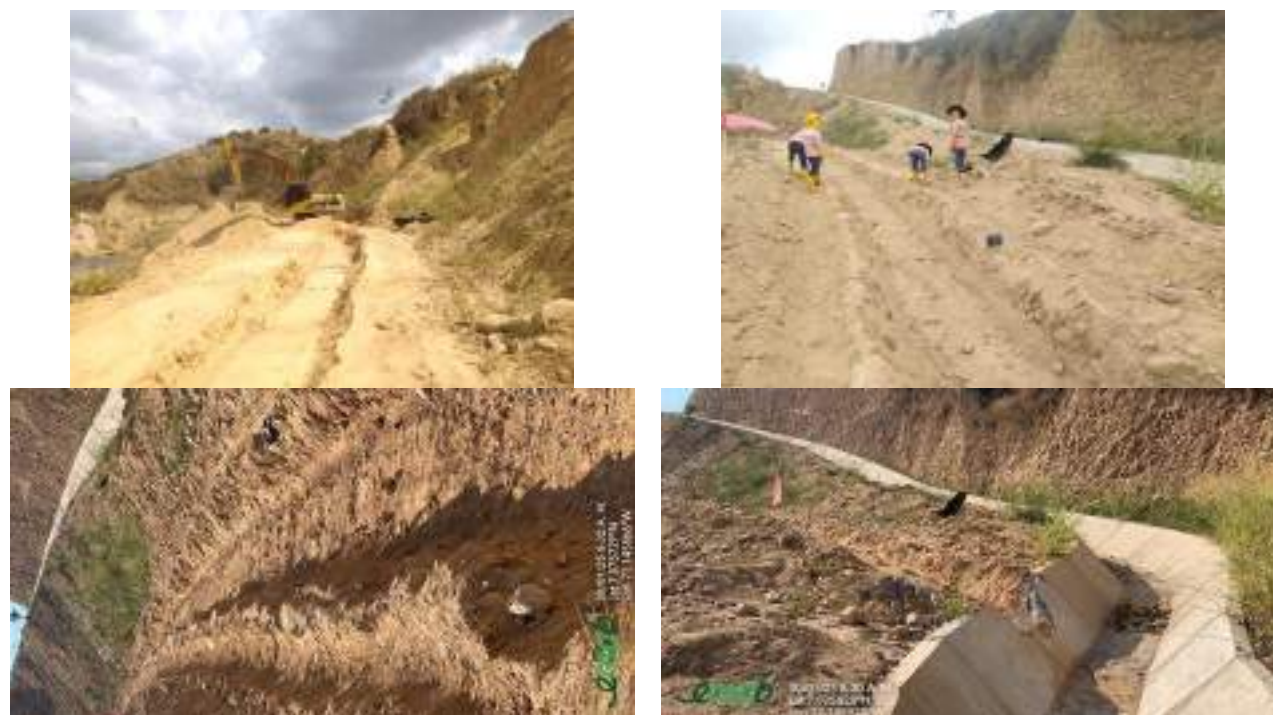
Ilustración 3 Construcción canales para manejo de aguas lluvias y escorrentía, enero de 2025
