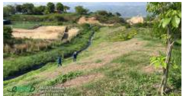
EM4- Canal celda 4 vía malpaso
