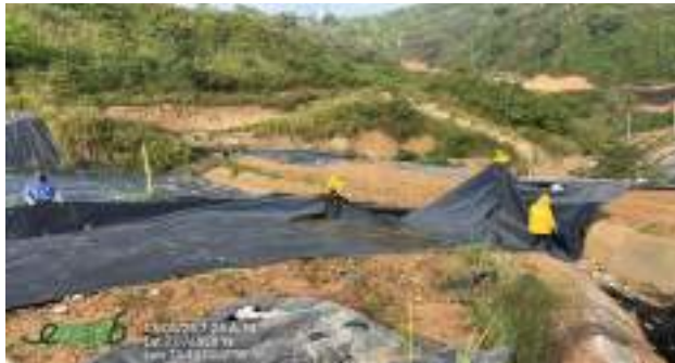
Ilustración Actividades de cierre y clausura celda de contingencia y celda de respaldo 1, 2025
