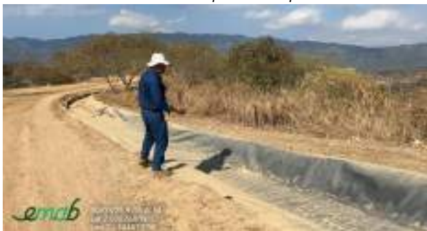
EM5- Canal Celda 1 parte alta
